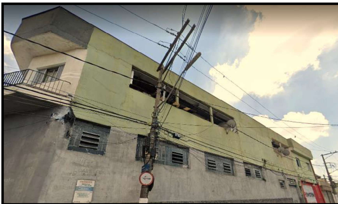
Imagem 8 – Vista lateral imóveis, parte superior
