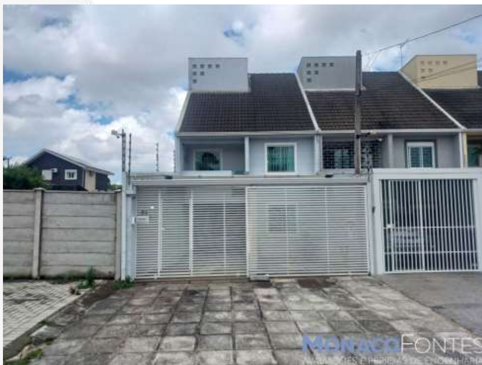
Na imagem acima, tem-se uma tomada da testada do imóvel, onde nota-se a acessibilidade direta do terreno em relação a Rua Líbia.
