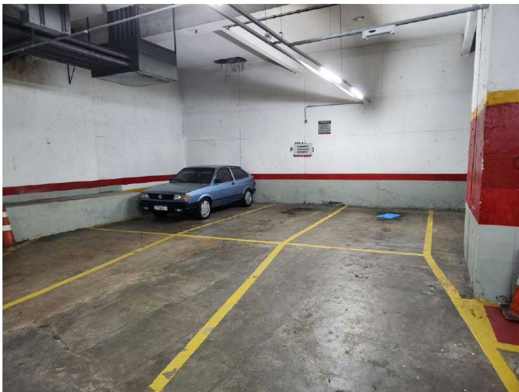
Imagem 20: Vista parcial do estacionamento
