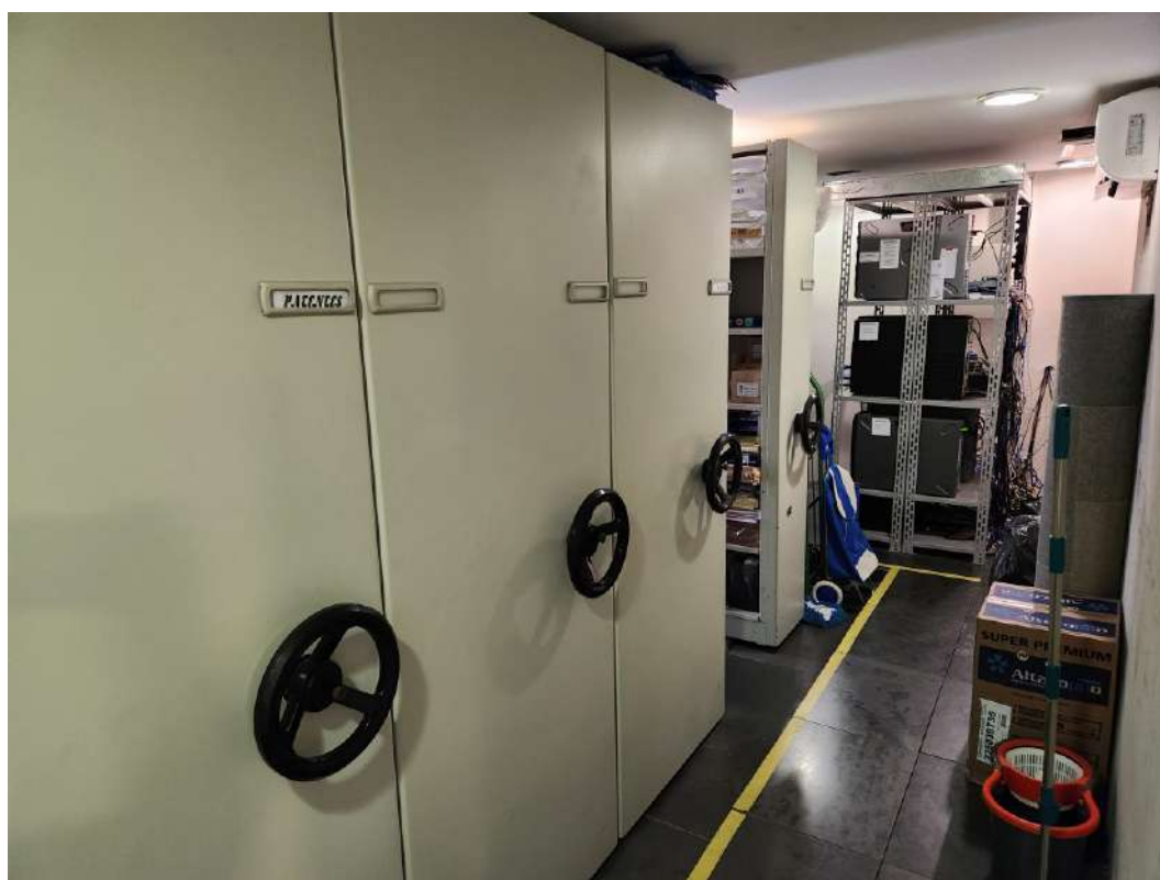
Imagem 16: Detalhe do Almojarifado
