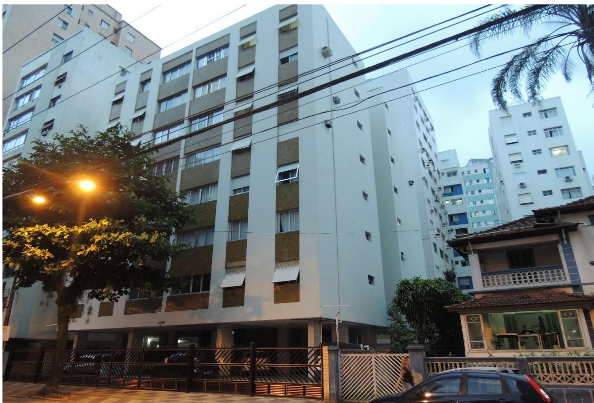
FOTO 01 – Vista parcial da fachada principal do Condomínio Edifício Andrea.
