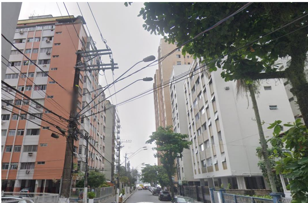
FOTO 03 – Vista parcial da Rua Jacob Emmerich (sentido Praia) e a direita o Edifício Andréa.
