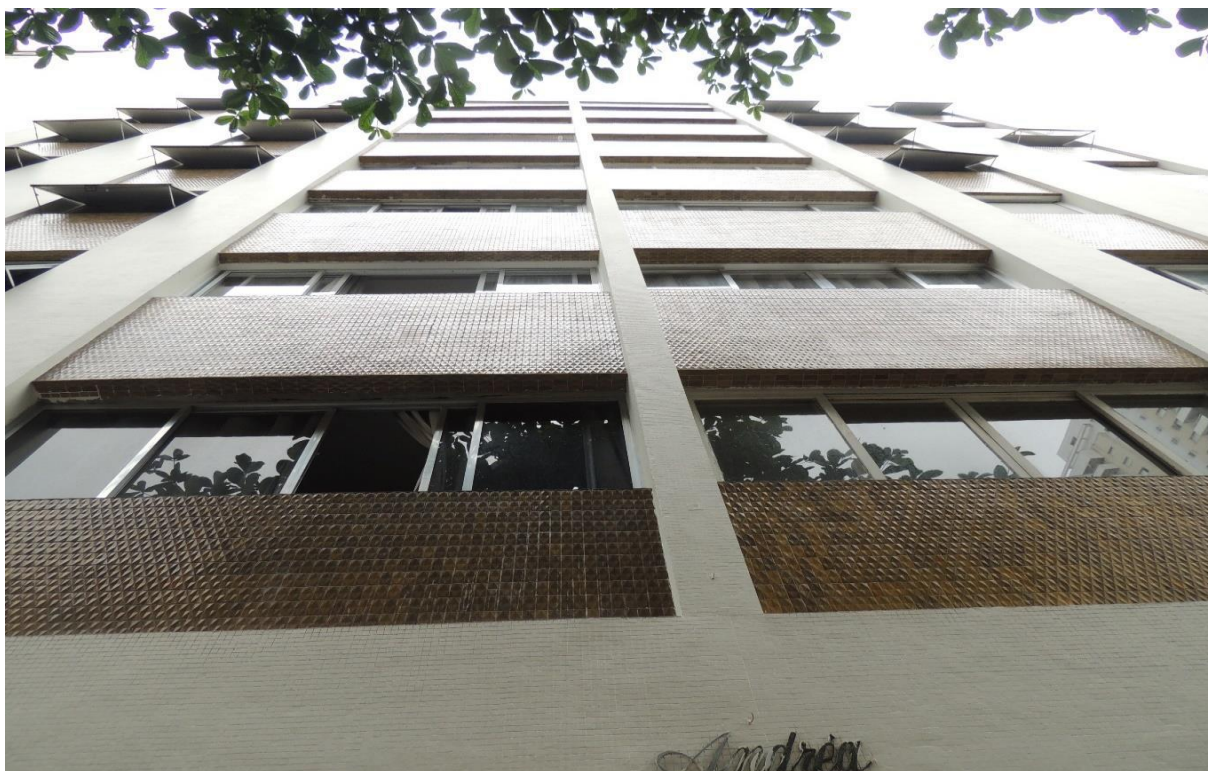
FOTO 02 – Detalhe da fachada principal do Edifício Andrea onde está situado o imóvel avaliando.
