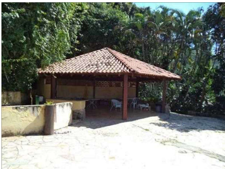
Vista geral do condomínio
