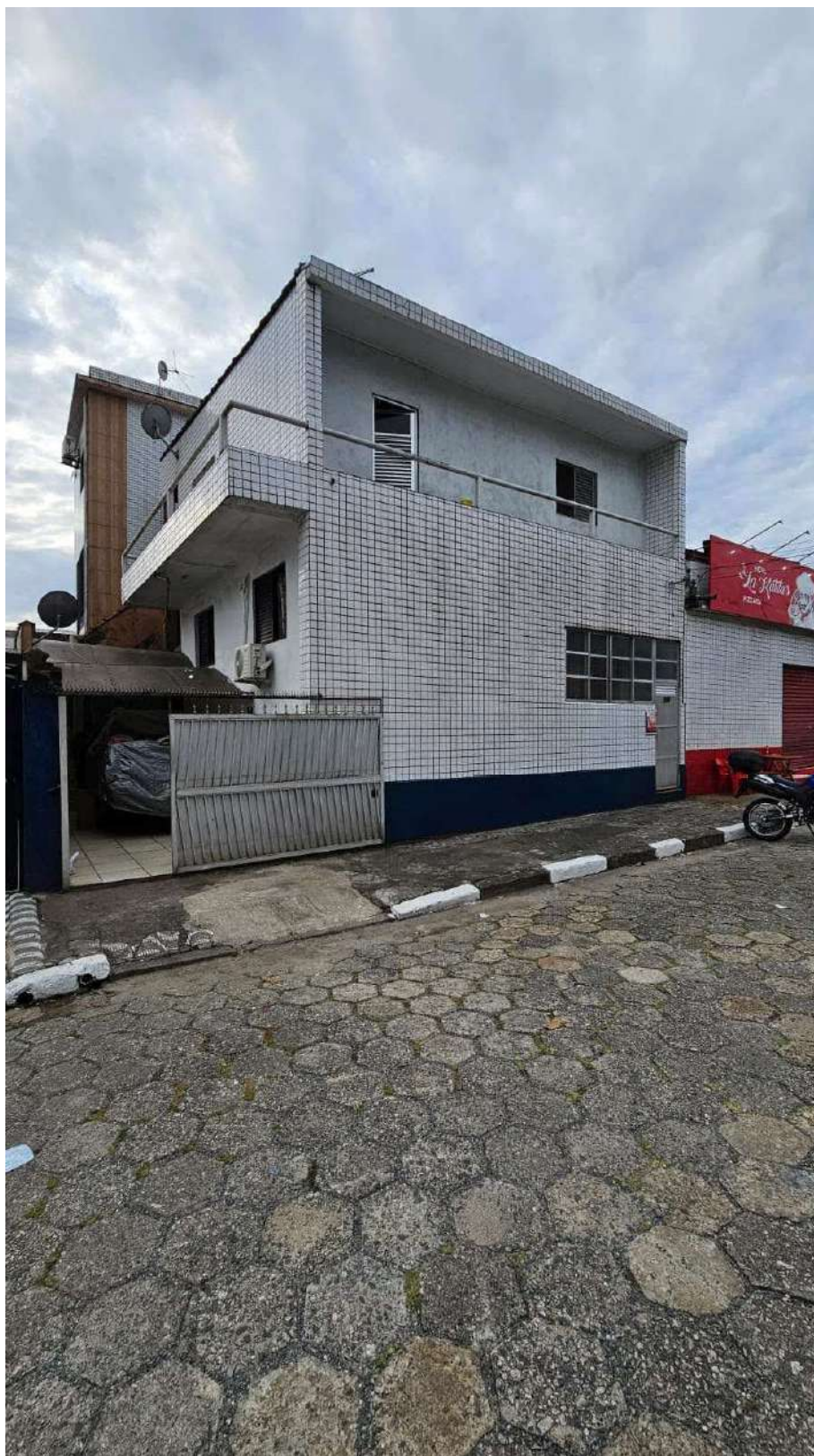
Foto 44 – Vista frontal do imóvel, localizado no 1º pavimento
