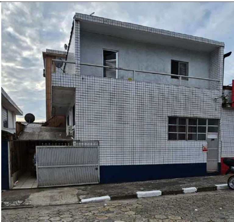
Fig. 16 Vista Frontal do imóvel localizado na parte superior
