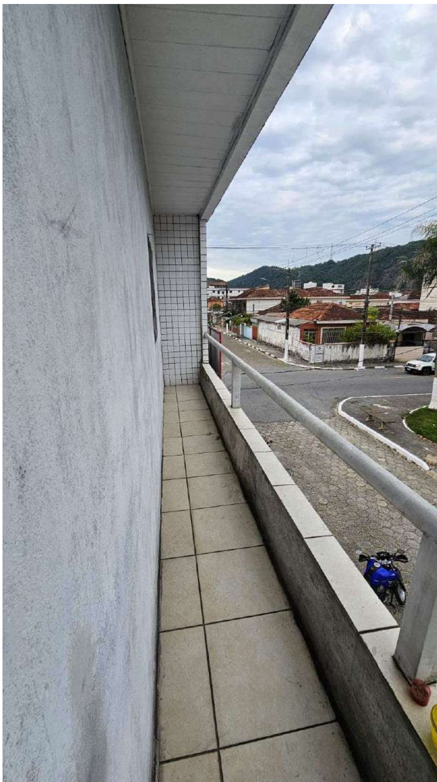
Foto 33 – Sacada de ventilação
