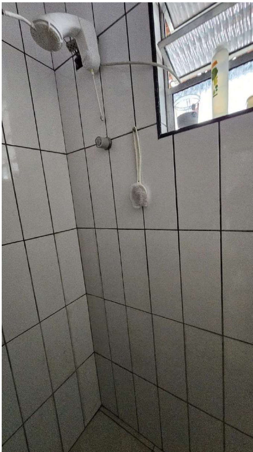
Foto 31 – Banheiro do imóvel
