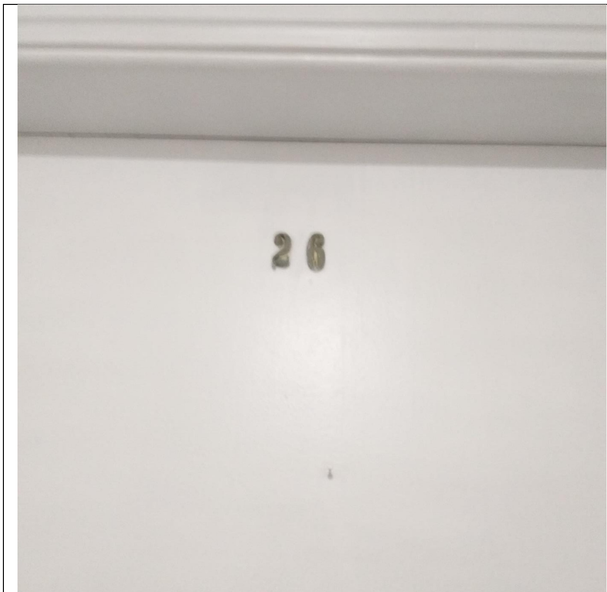
FOTO 4.4.1 – Identificação do apartamento avaliado – apartamento nº 26 do Condomínio Edifício “Oasis” – R. Professor Pirajá da Silva, 607, bairro Aparecida, Santos - SP.
