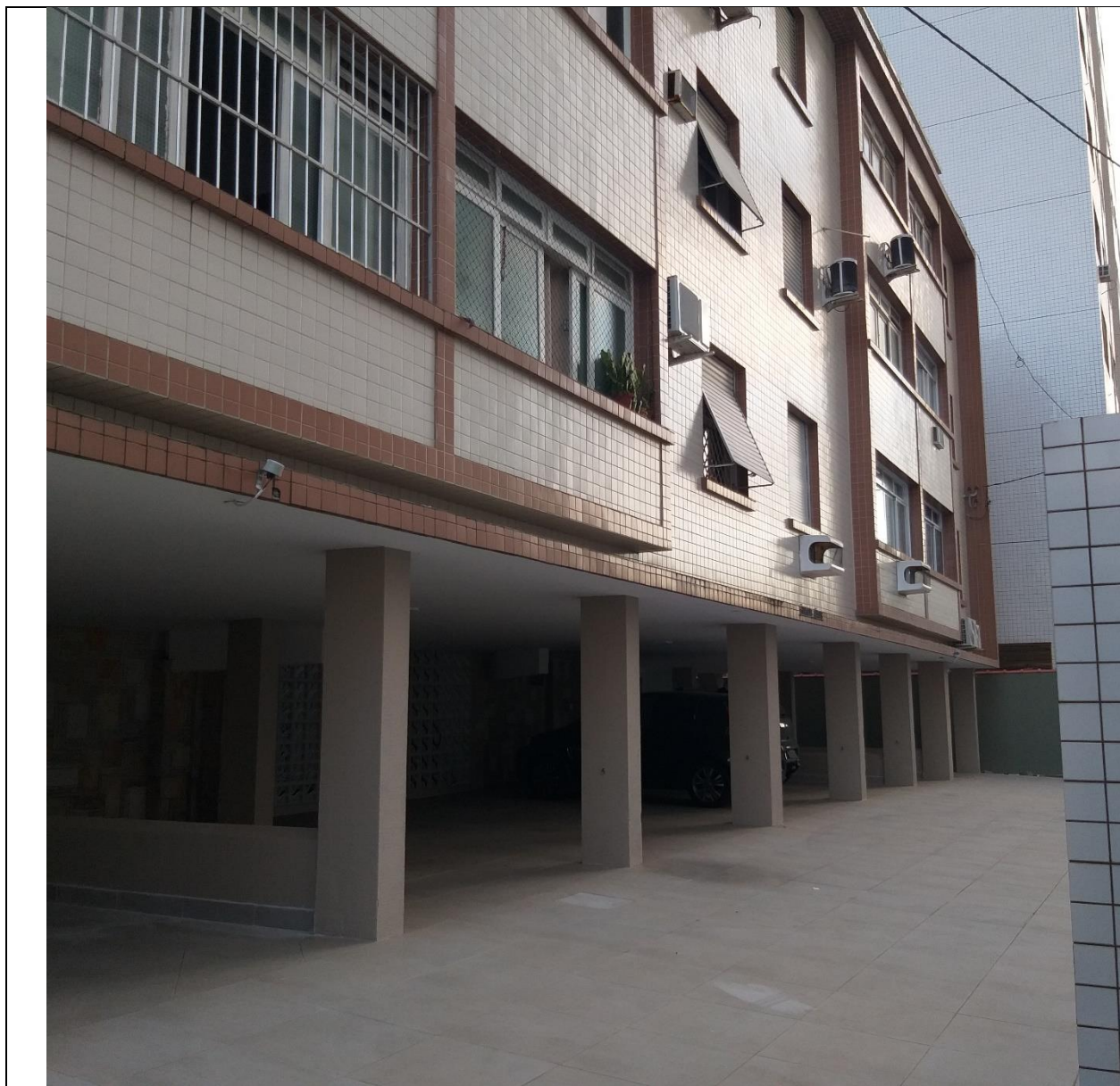
FOTO 4.4.7 - Tomada mostrando as características do condomínio.
