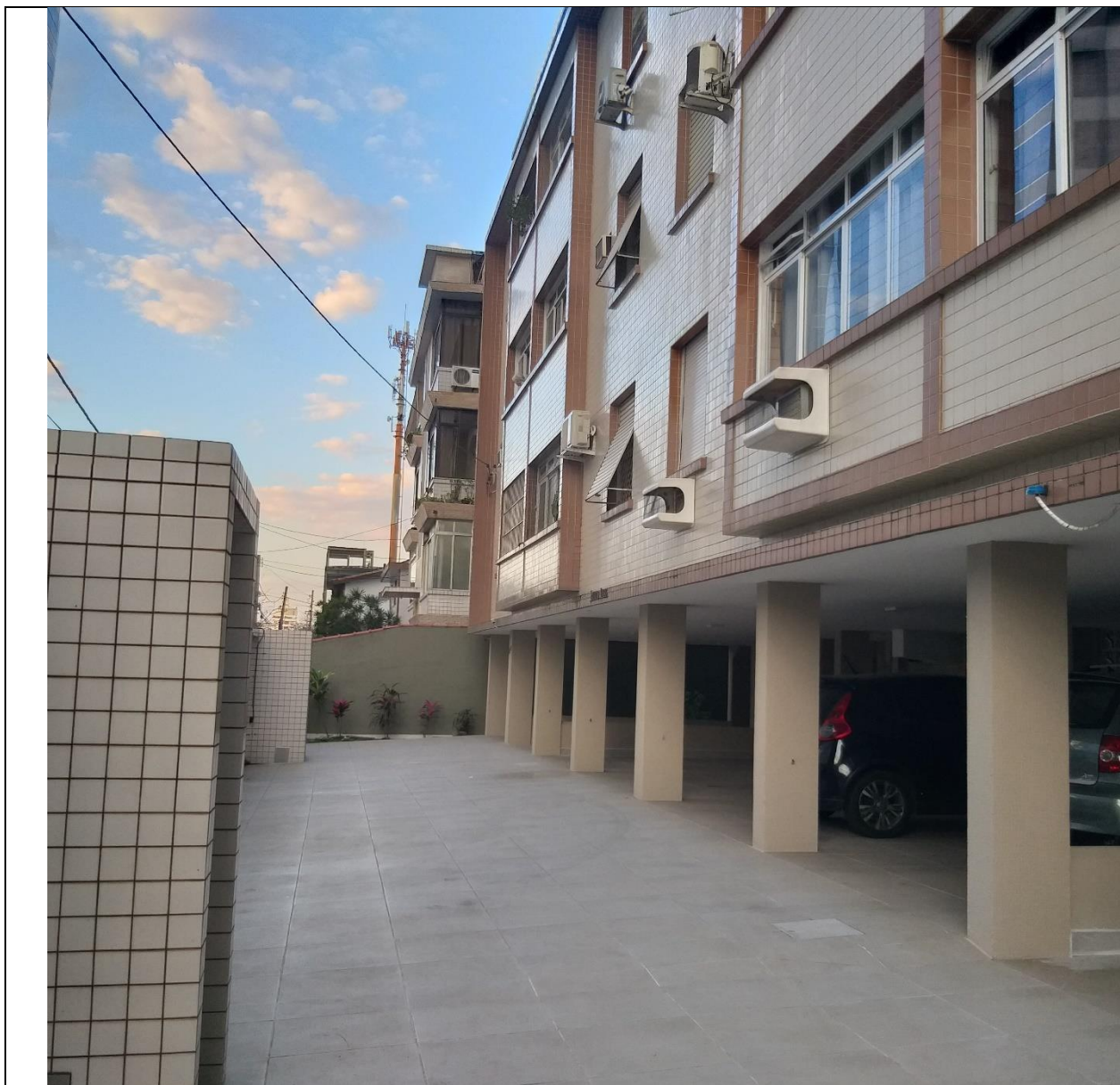
FOTO 4.4.6 - Tomada mostrando as características do condomínio.
