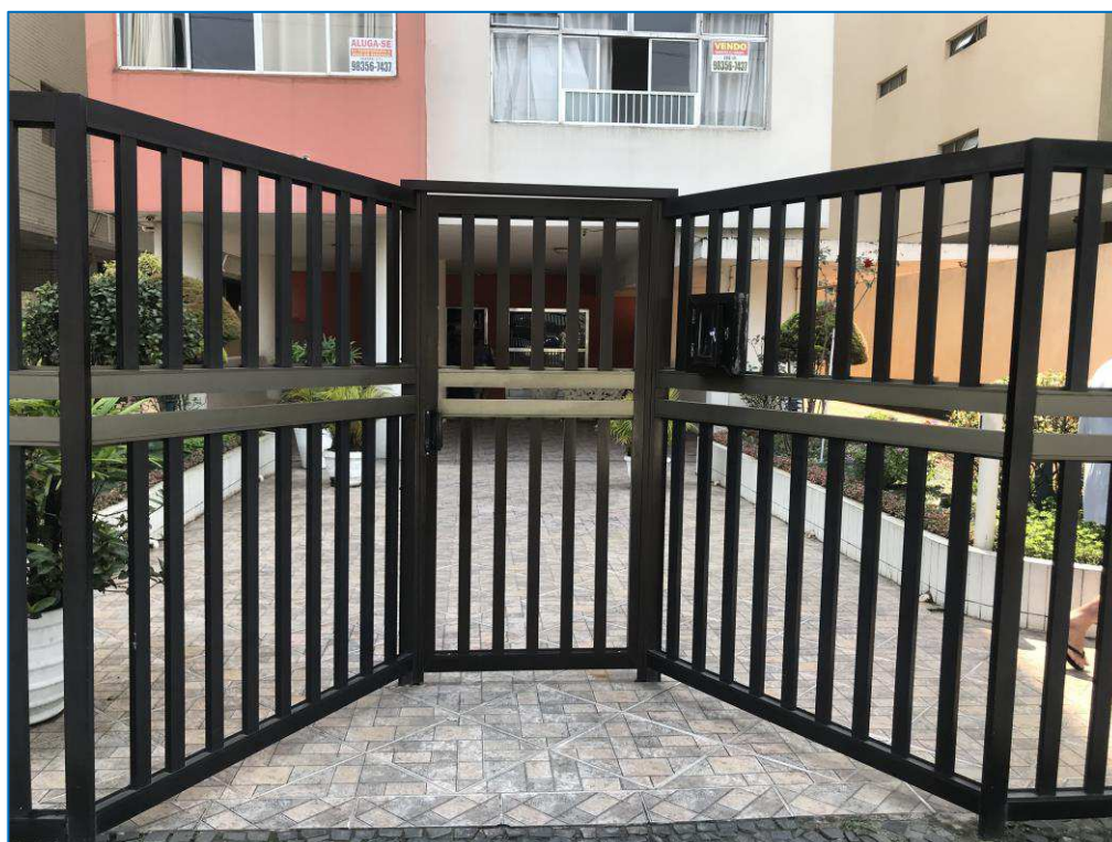
FACHADA E ENTRADA DE PEDESTRES.
