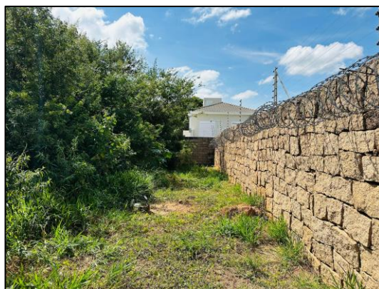
Figura 8 - Aspecto geral do imóvel
