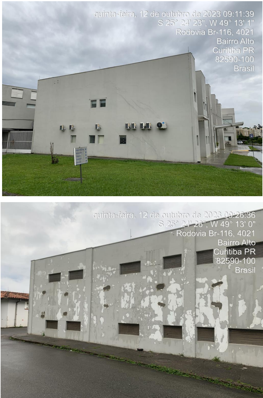
Figura 7: Estado de conservação do imóvel
