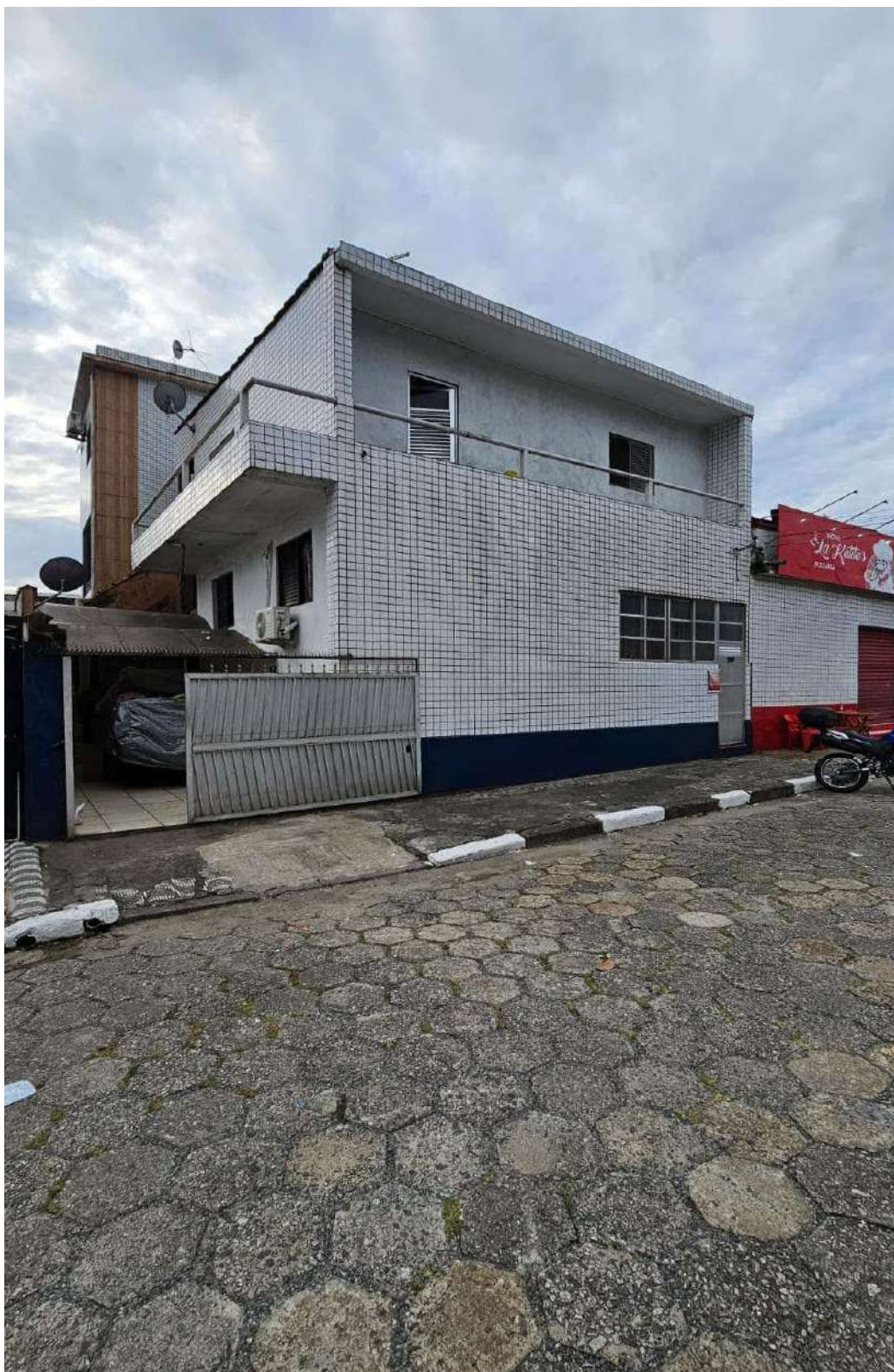
Fig. 3 Imóvel localizado na parte superior da edificação
