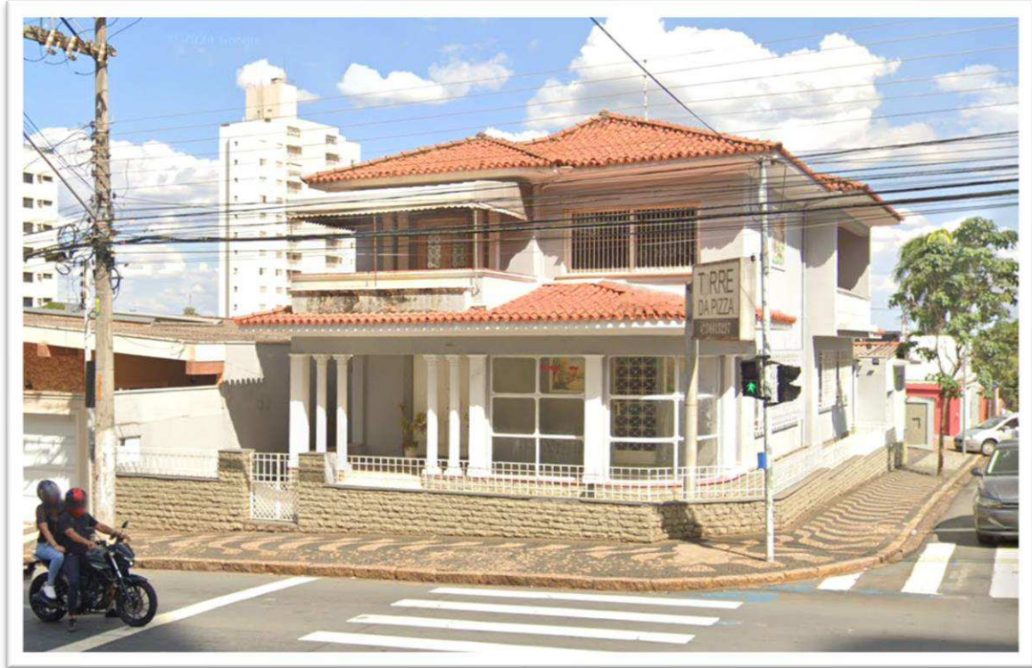
Figura 4 - Vista frontal do imóvel
