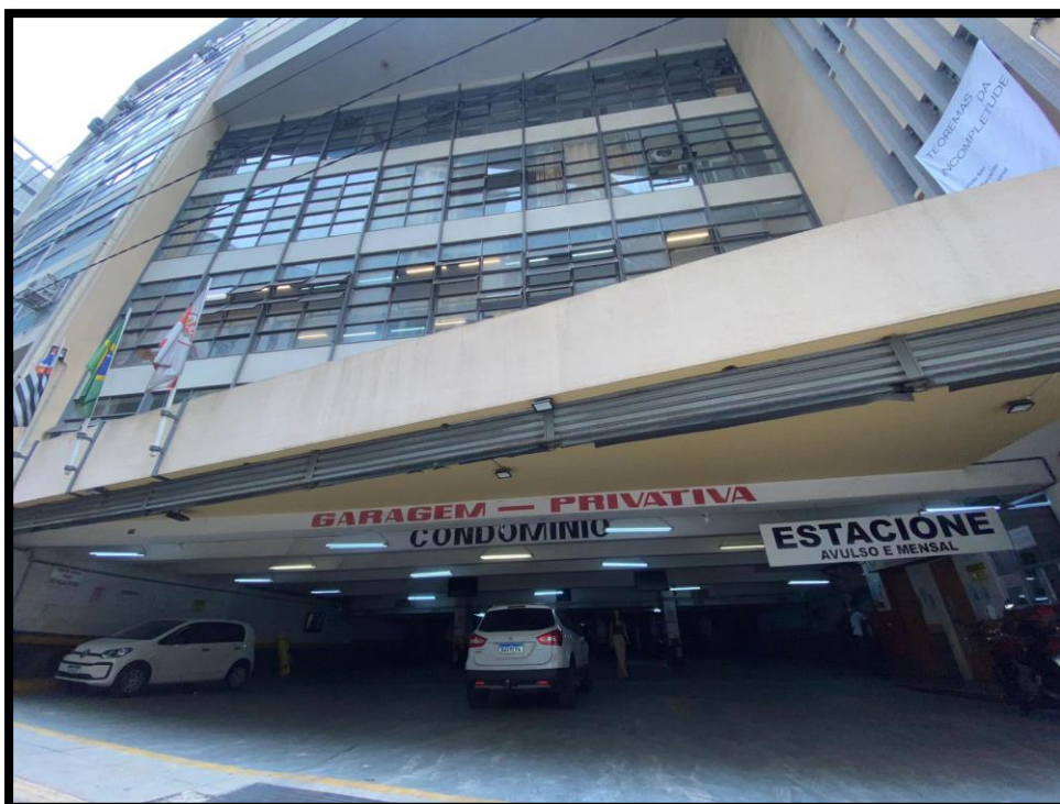
Imagem 2 – Fachada do edifício
