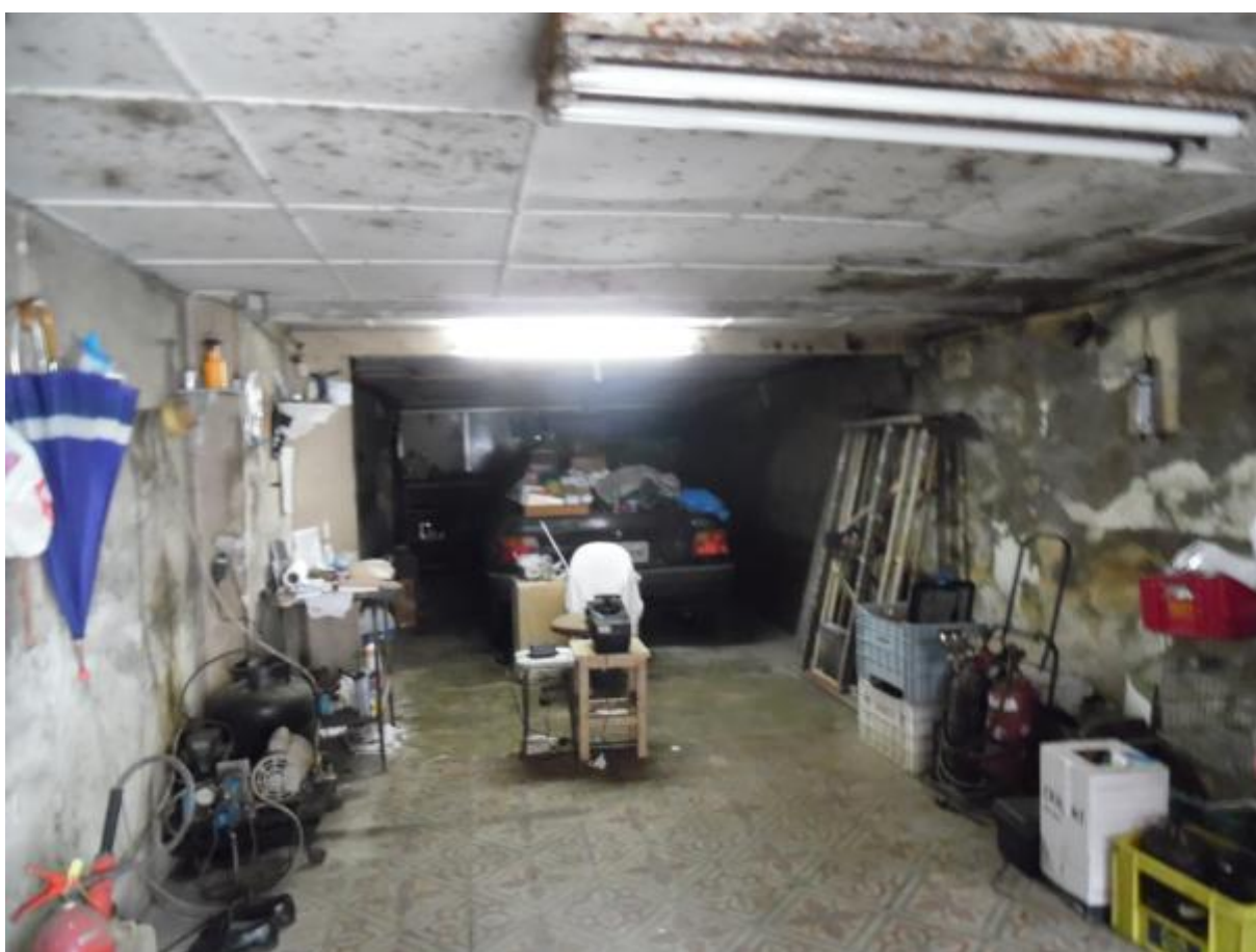
FOTO 03:- Vista da garagem do imóvel.
