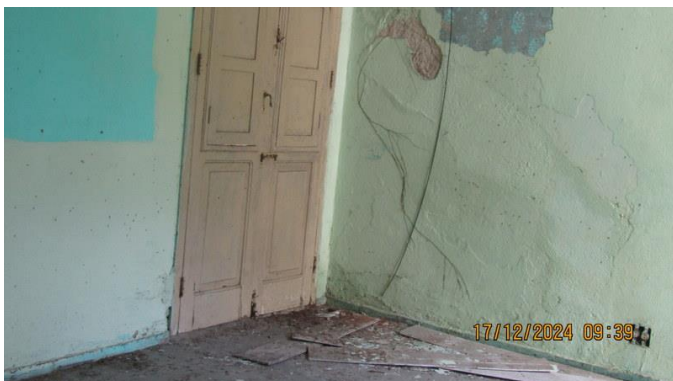
Foto 48 - Vista de outra sala do imóvel "B".
