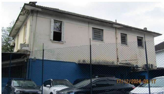
Foto 5 - Vista da fachada do imóvel "A".
