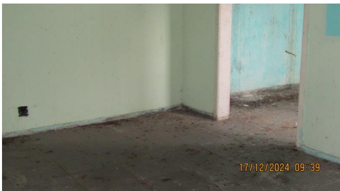
Foto 57 – Vista de outra sala do imóvel “B”.
