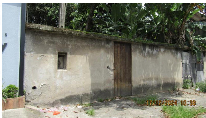
Foto 74 – Outra vista da frente do imóvel “C”.
