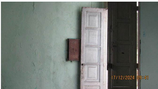
Foto 45 - Vista da porta de acesso ao imóvel "B".
