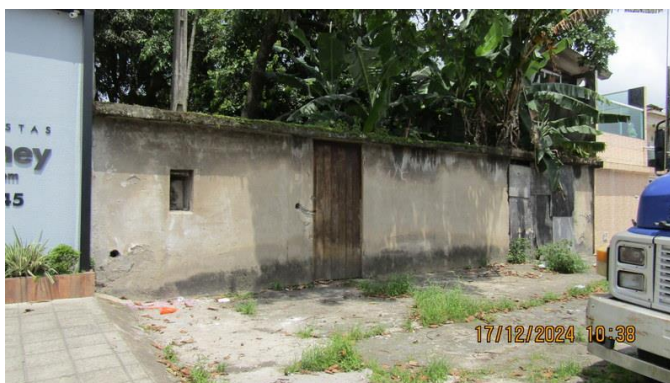
Foto 73 – Outra vista da frente do imóvel “C”.
