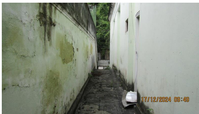
Foto 44 - Outra vista do corredor de acesso ao imóvel "B".
