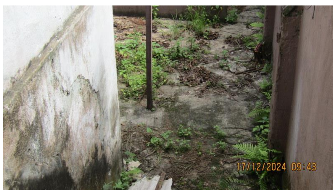
Foto 62 – Outra vista dos fundos do imóvel “B”.
