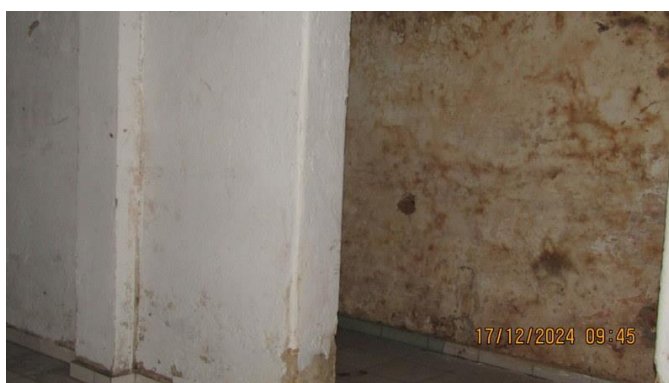
Foto 68 – Detalhes da alvenaria do salão no piso térreo do imóvel “B”.
