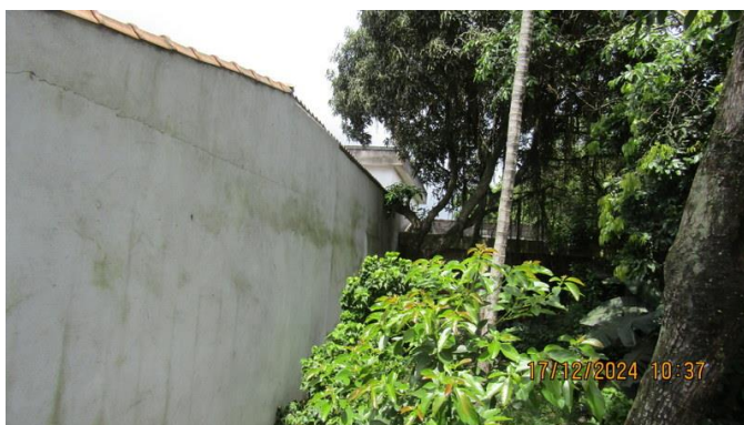
Foto 79 – Outra vista interna do imóvel “C”.
