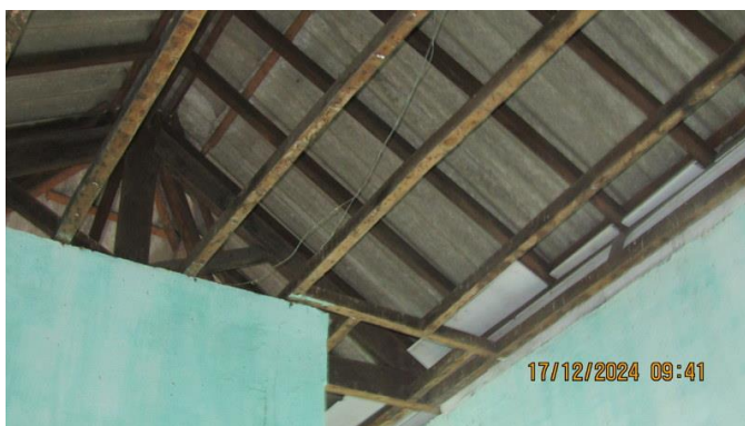
Foto 55 – Outro detalhe da estrutura do telhado do imóvel "B".
