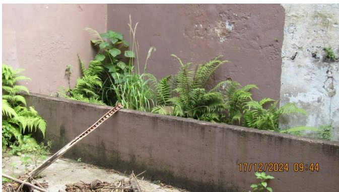
Foto 60 – Vista dos fundos do imóvel “B”.
