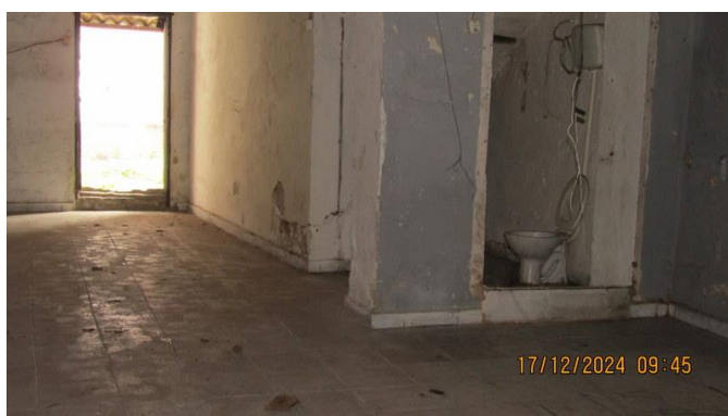
Foto 65 – Vista do salão localizado no piso térreo do imóvel “B”.
