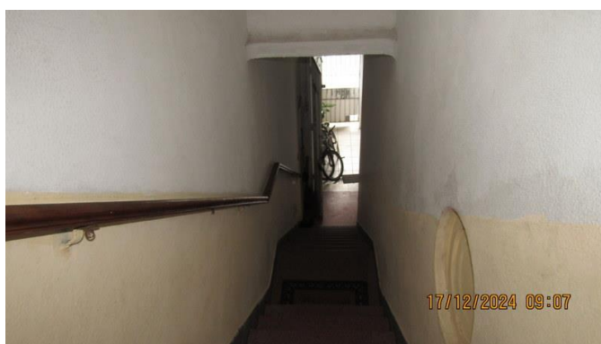
Foto 8 - Vista da escadaria de acesso ao imóvel "A".
