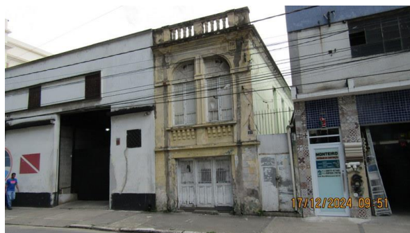
Foto 41 – Outra vista da fachada do imóvel “B”.
