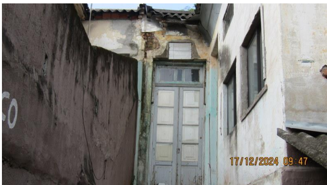
Foto 63 – Outra vista dos fundos do imóvel “B”.
