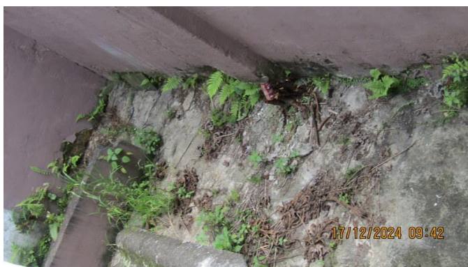
Foto 61 – Outra vista dos fundos do imóvel “B”.
