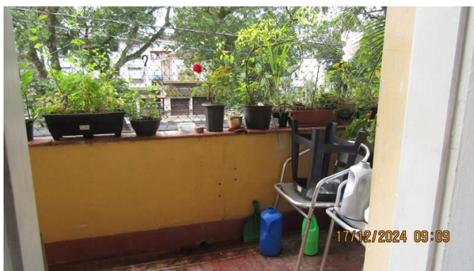
Foto 10 - Outra vista da varanda do imóvel "A".
