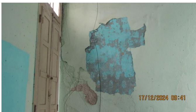
Foto 49 – Detalhes do revestimento da parede do imóvel "B".
