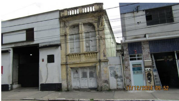
Foto 40 - Vista da fachada do imóvel “B”.
