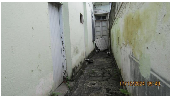
Foto 42 - Vista do corredor de acesso ao imóvel "B".
