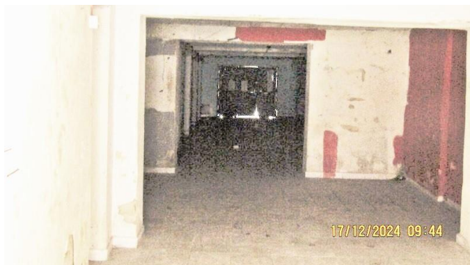
Foto 66 – Outra vista do salão localizado no piso térreo do imóvel “B”.
