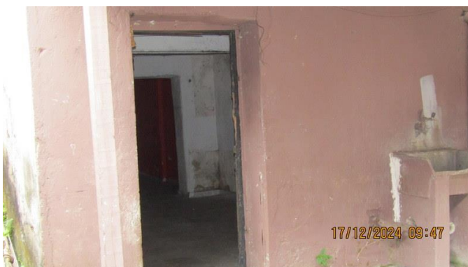
Foto 64 – Outra vista dos fundos do imóvel “B”.
