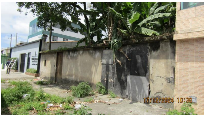
Foto 72 – Outra vista da frente do imóvel “C”.
