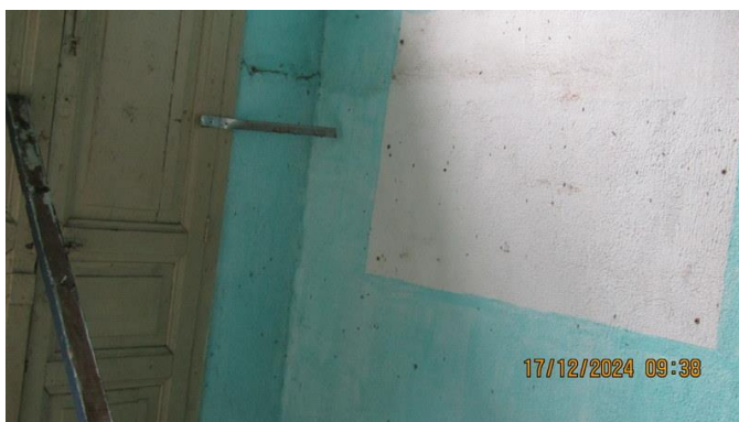
Foto 46 - Detalhes da sala do imóvel "B".
