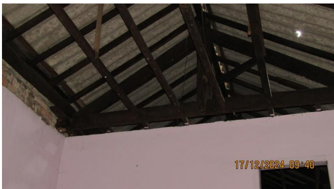
Foto 54 - Detalhes da estrutura do telhado do imóvel "B".
