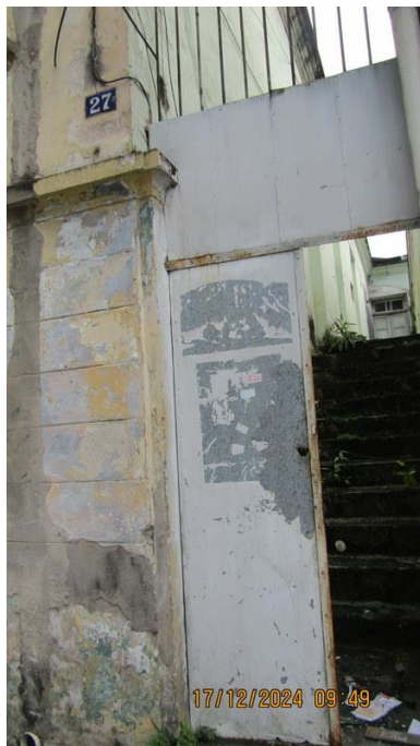
Foto 39 – Vista do portão de acesso ao imóvel “B”.
