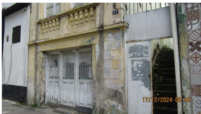
Foto 38 – Outra vista da fachada do imóvel “B”.
