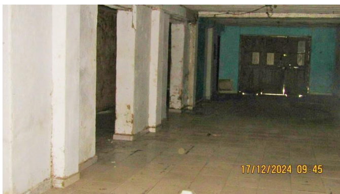
Foto 67 – Outra vista do salão localizado no piso térreo do imóvel “B”.
