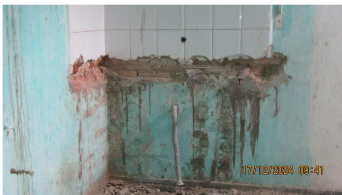
Foto 52 – Outro detalhe do revestimento da parede do imóvel "B".
