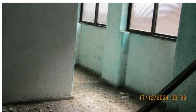
Foto 47 - Outra vista da sala do imóvel "B".
