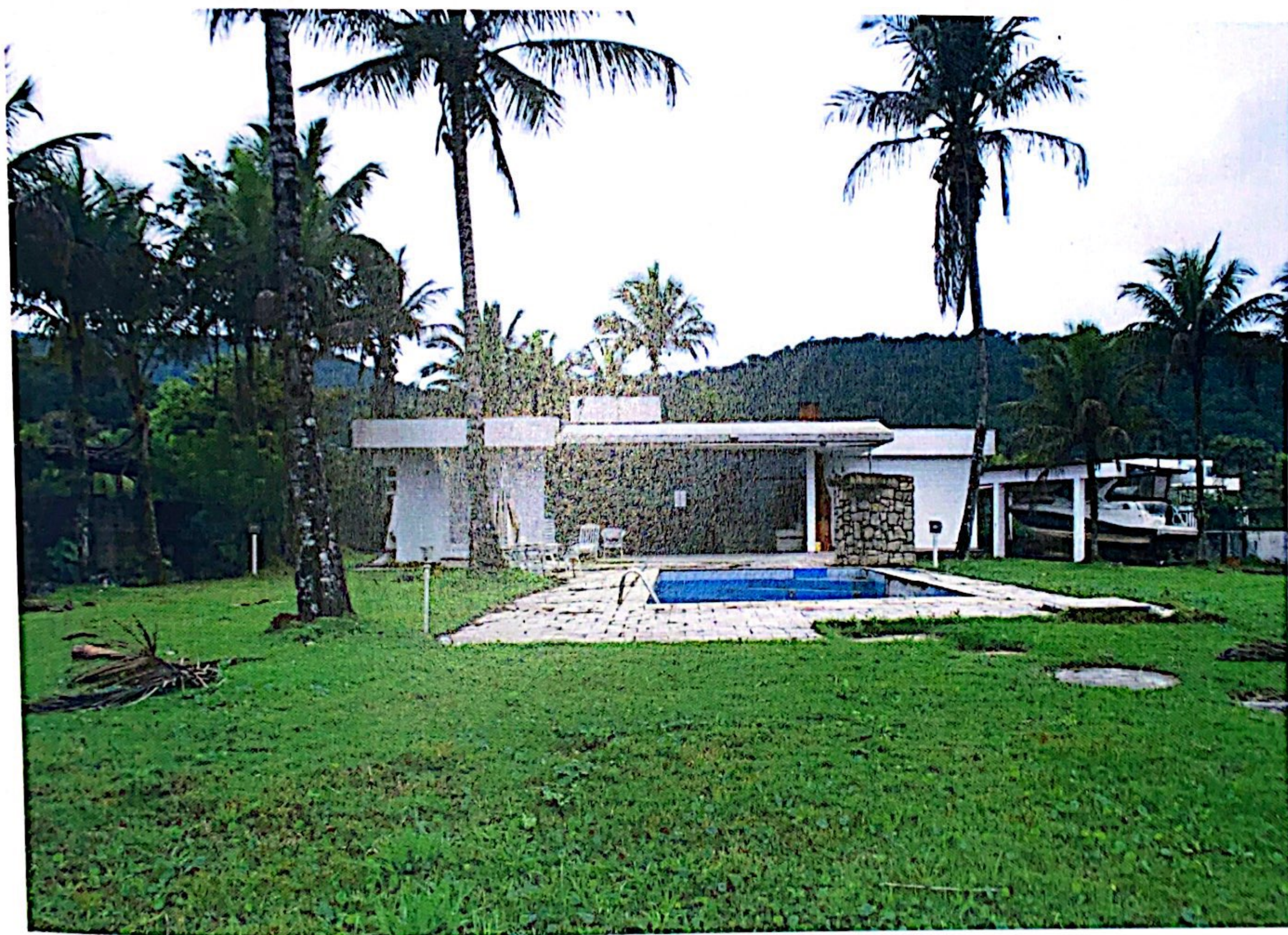
FOTO 02 - Vista da fachada de fundos voltada para o Canal de Bertioga.
