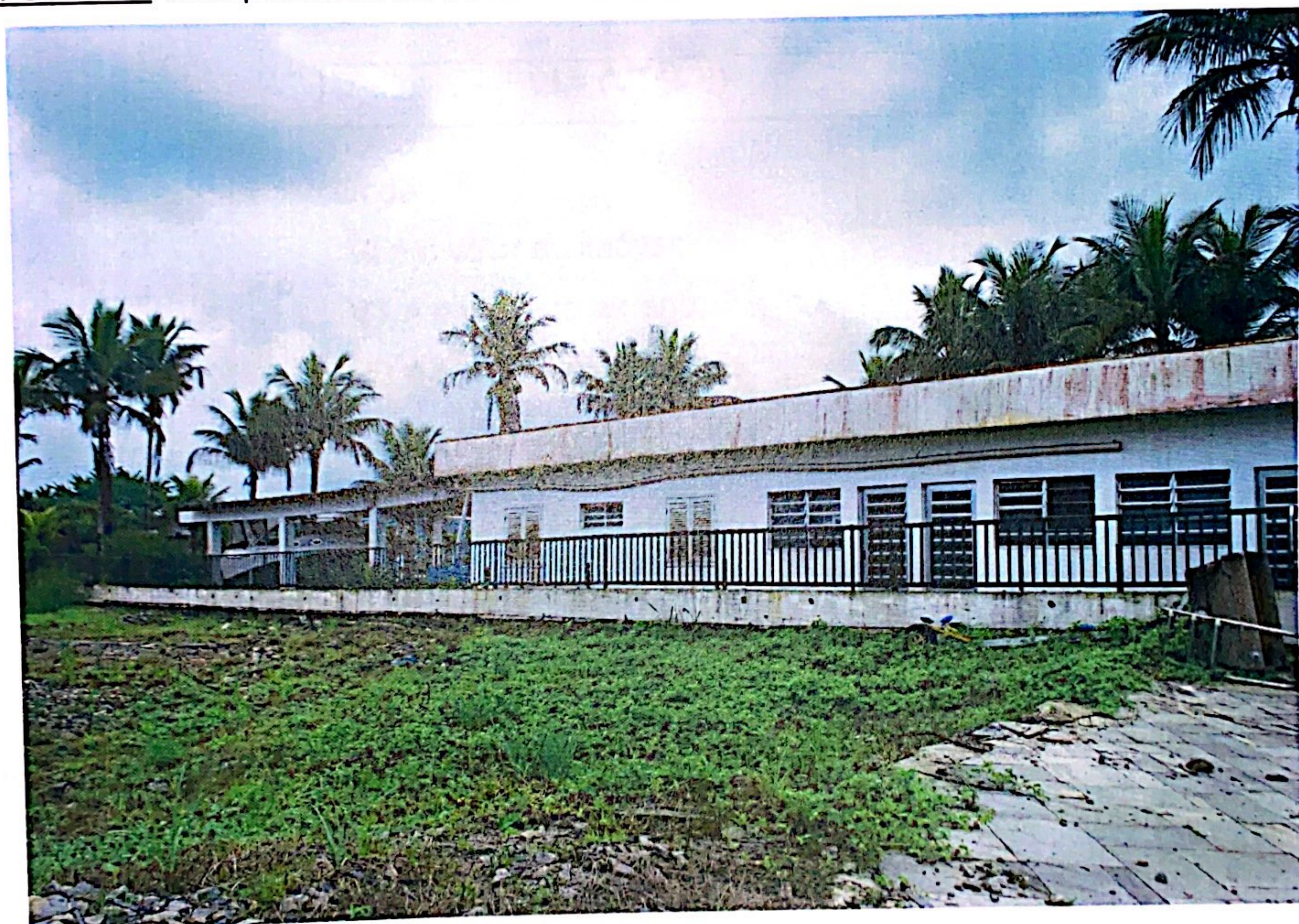
FOTO 06 - Vista parcial fachada lateral do imóvel.
