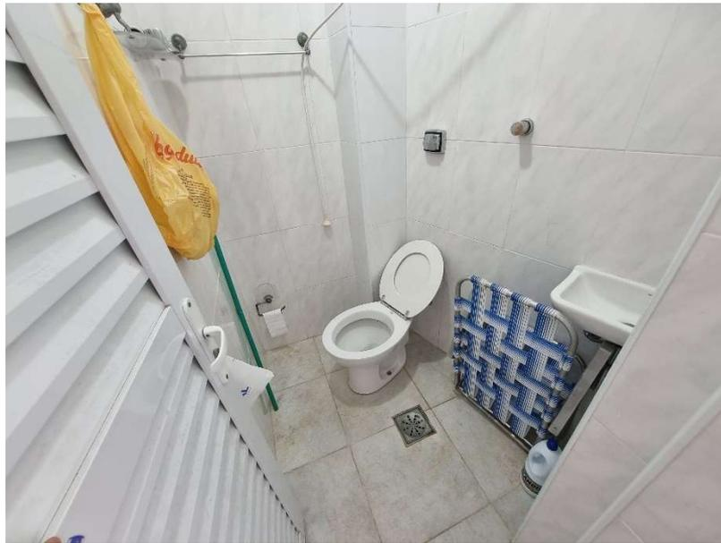
**Foto 16** - Vista do banheiro de serviço da unidade privativa 33, unidade similar ao apartamento avaliando, apresentando as seguintes características construtivas: piso e paredes em revestimento cerâmico e teto em pintura látex sobre massa corrida com molduras de gesso; esquadrias em alumínio.
