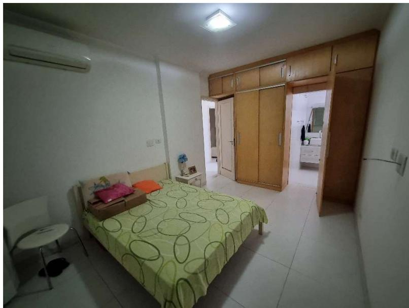
**Foto 23** - Vista da suíte da unidade privativa 33, unidade similar ao apartamento avaliando, apresentando as seguintes características construtivas: piso em revestimento cerâmico, paredes e teto em pintura látex sobre massa corrida com molduras de gesso; esquadrias da porta em madeira e da janela em alumínio.
