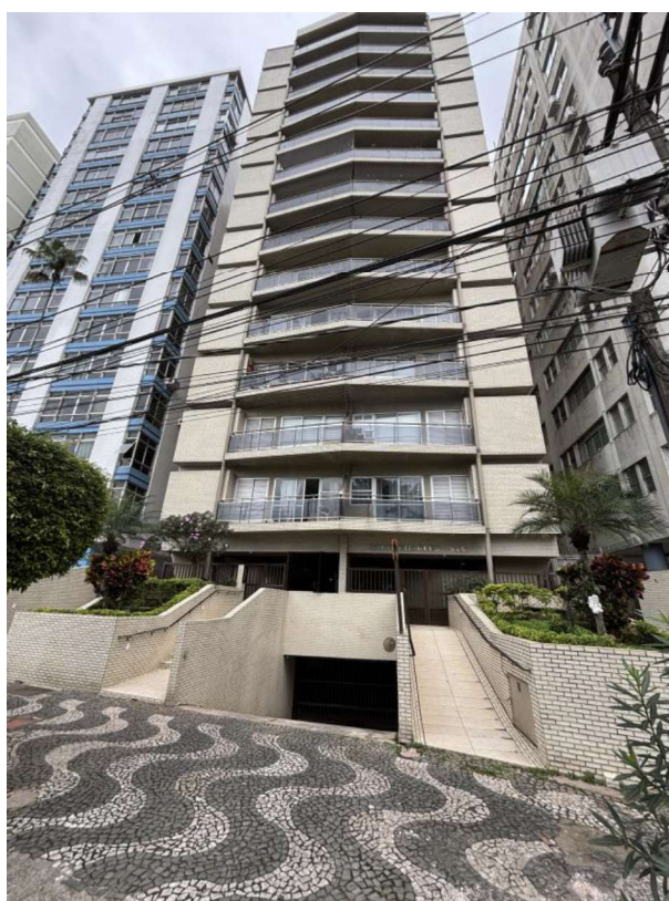
Figura 3: Vista geral da fachada frontal do Edifício Saint Charles.
