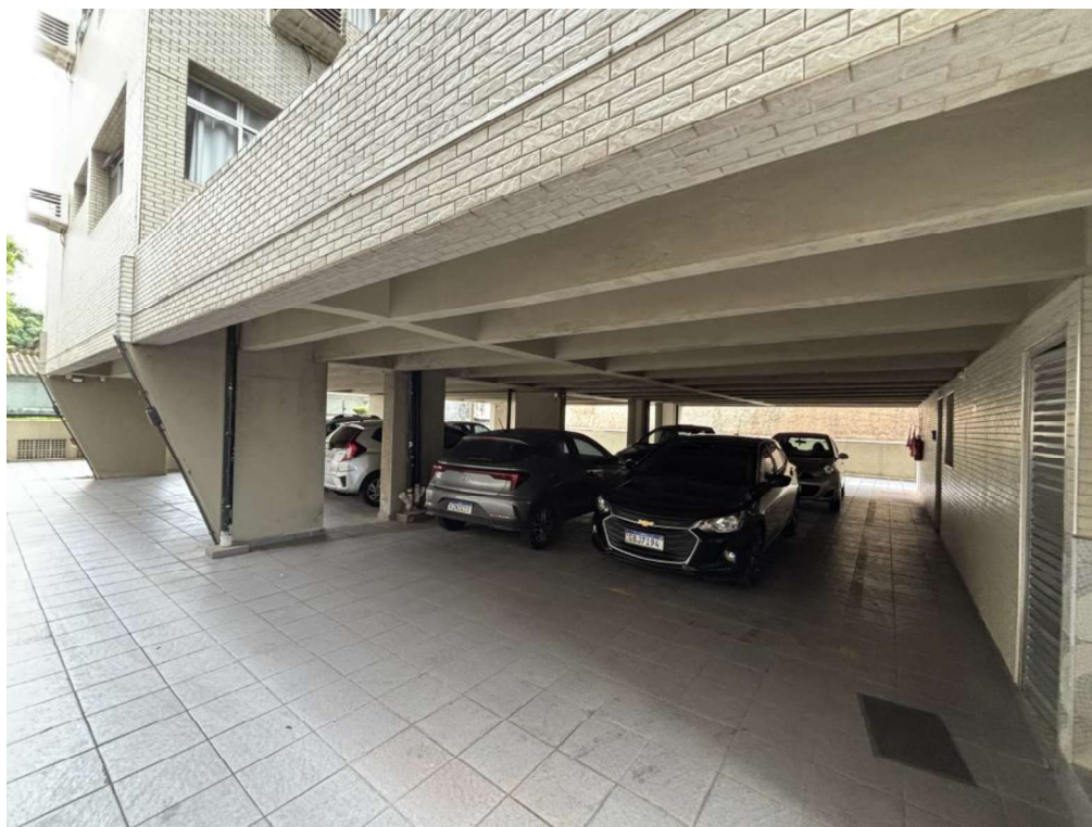
Figura 5: Vista genérica da garagem térrea.
