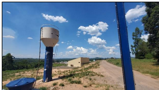
Figura 115 – Aspecto geral do imóvel avaliando
