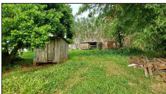
Figura 56 - Aspecto geral das benfeitorias do imóvel avaliando
