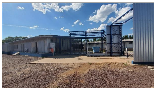
Figura 117 - Aspecto geral do imóvel avaliando
