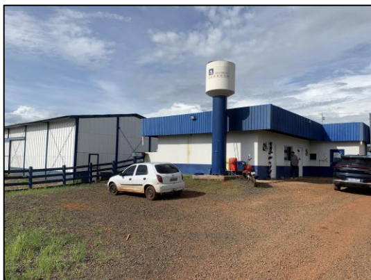
Figura 8 - Aspecto geral do imóvel avaliando
