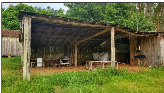
Figura 54 - Aspecto geral das benfeitorias do imóvel avaliando
