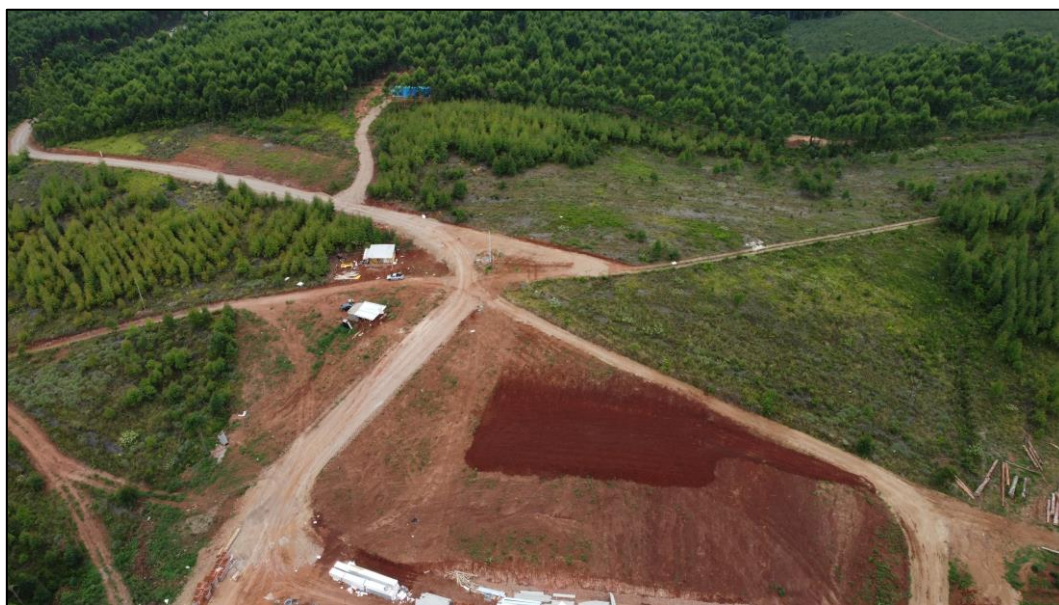
Figura 93 - Aspecto geral do imóvel avaliando
