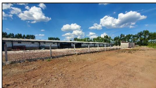
Figura 119 - Aspecto geral do imóvel avaliando
