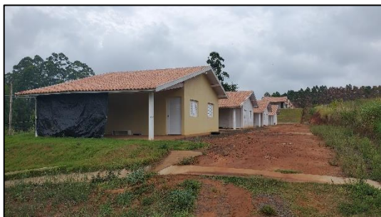
Figura 58 - Aspecto geral das benfeitorias do imóvel avaliando
