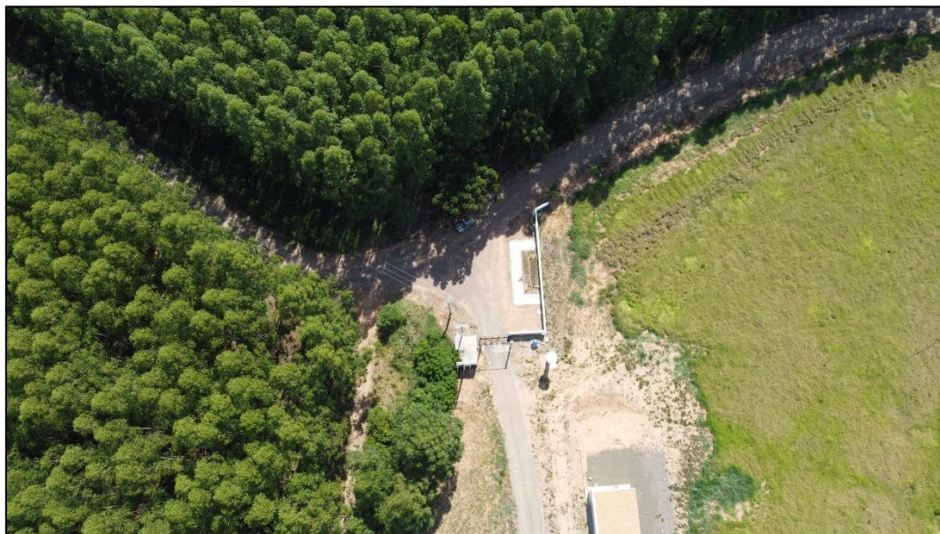
Figura 108 - Aspecto geral da entrada do imóvel avaliando
