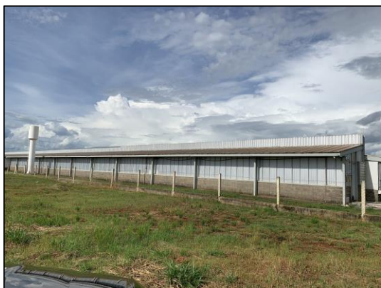
Figura 10 - Aspecto geral do imóvel avaliando
