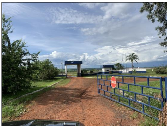
Figura 6 - Aspecto geral da entrada do imóvel avaliando
