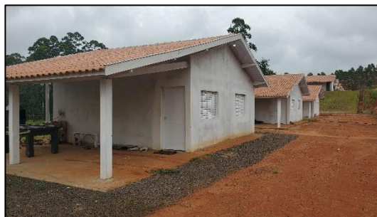
Figura 59 - Aspecto geral das benfeitorias do imóvel avaliando
