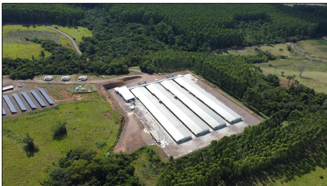
Figura 107 - Imagem aérea do imóvel avaliando
