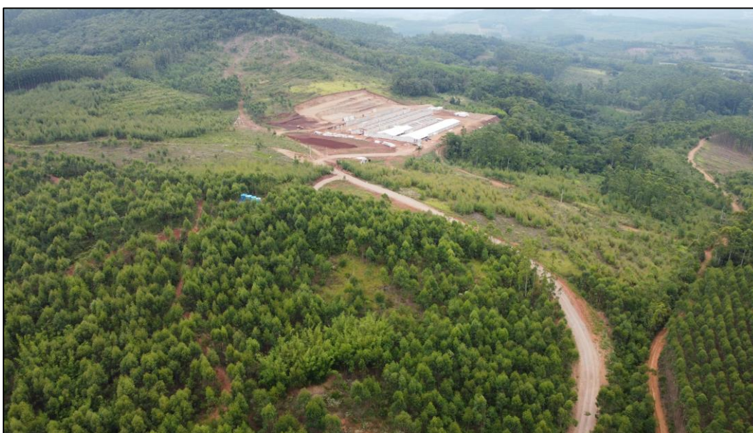
Figura 89 - Imagem aérea do imóvel avaliando
