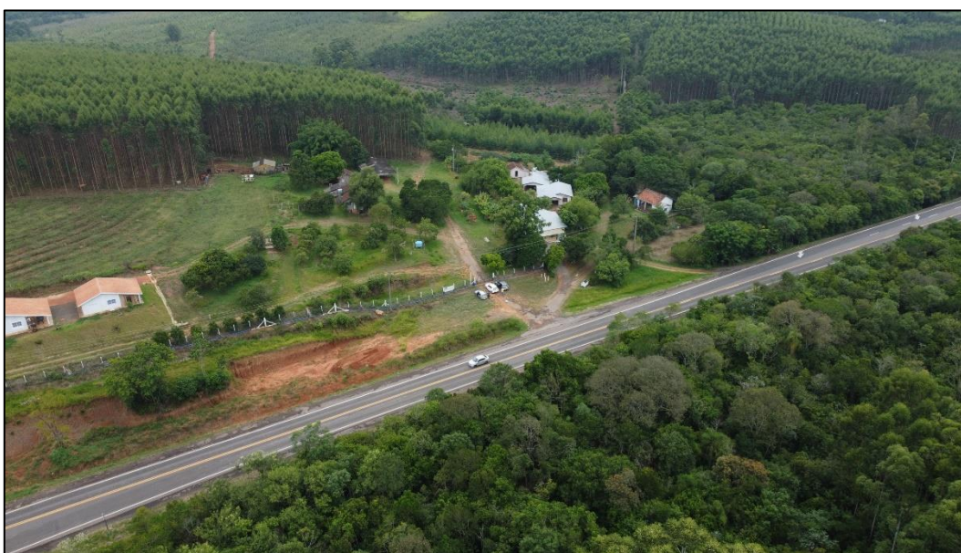
Figura 49 - Imagem aérea do imóvel avaliando
