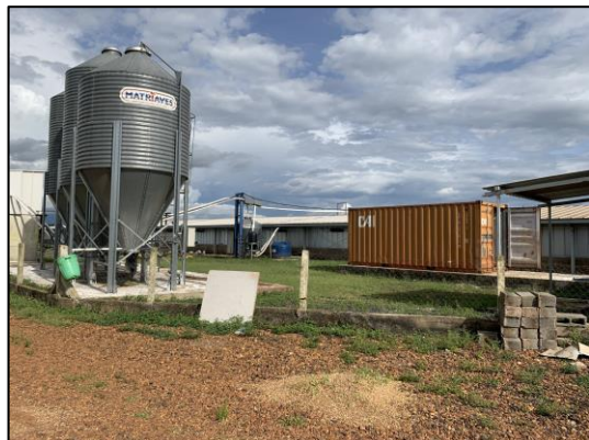
Figura 12 - Aspecto geral do imóvel avaliando
