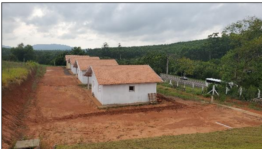
Figura 60 - Aspecto geral das benfeitorias do imóvel avaliando
