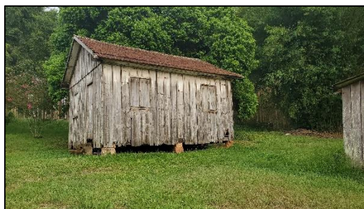
Figura 55 - Aspecto geral das benfeitorias do imóvel avaliando
