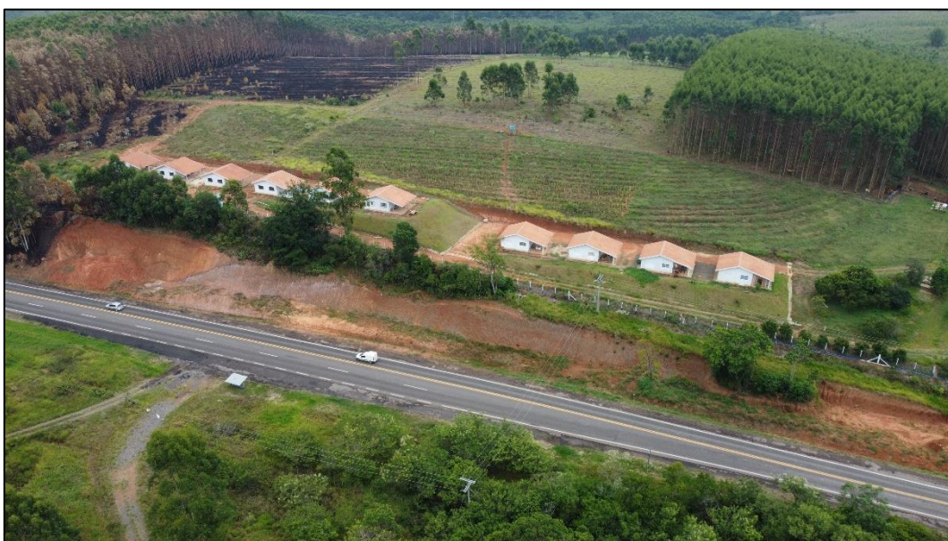
Figura 51 - Imagem aérea do imóvel avaliando
