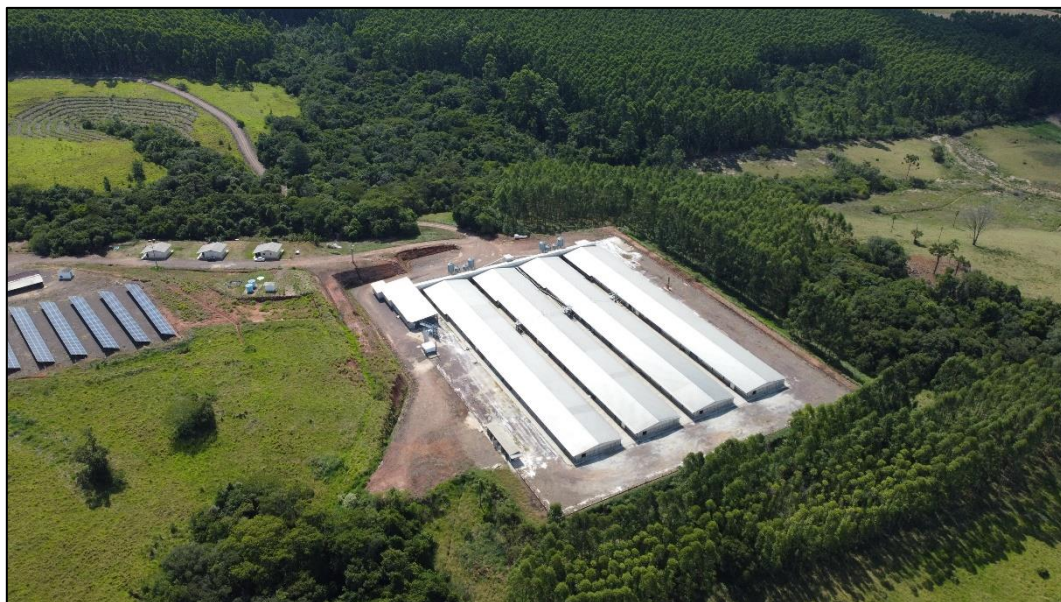
Figura 106 - Imagem aérea do imóvel avaliando
