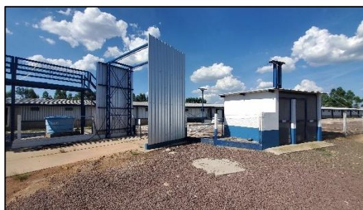
Figura 118 - Aspecto geral do imóvel avaliando
