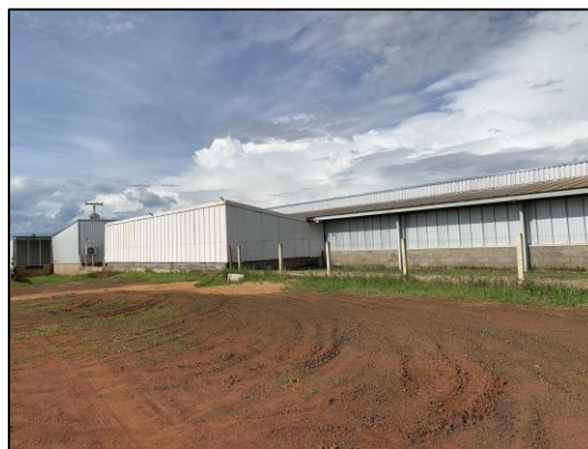
Figura 11 - aspecto geral do imóvel avaliando
