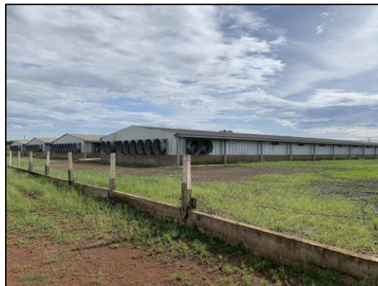
Figura 13 - Aspecto geral do imóvel avaliando
