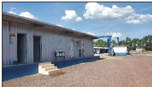
Figura 116 - Aspecto geral do imóvel avaliando
