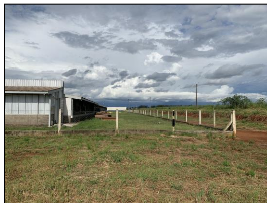
Figura 9 - Aspecto geral do imóvel avaliando
