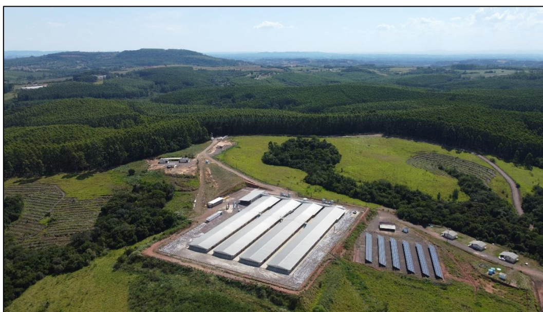
Figura 105 - Imagem aérea do imóvel avaliado
