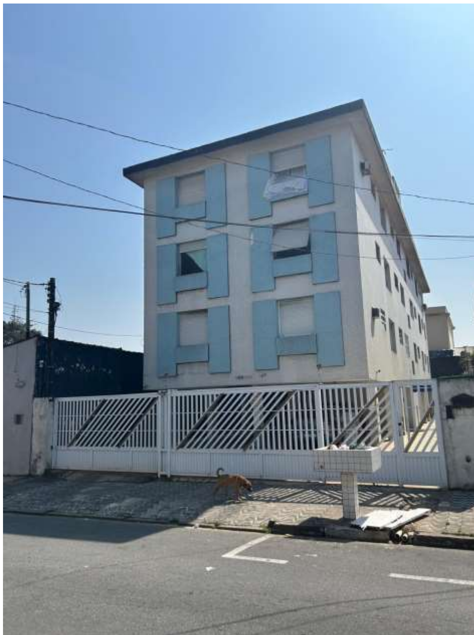
FOTO 1 – VISTA FRONTAL DA EDIFICAÇÃO
