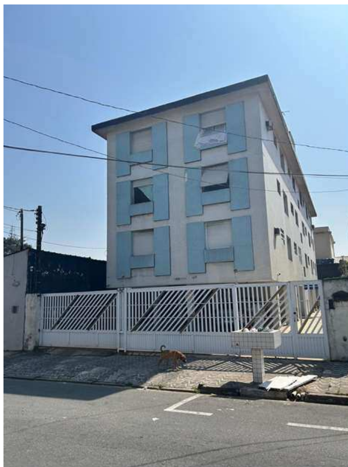
Foto 2 – Vista Frontal do Edifício Verona
