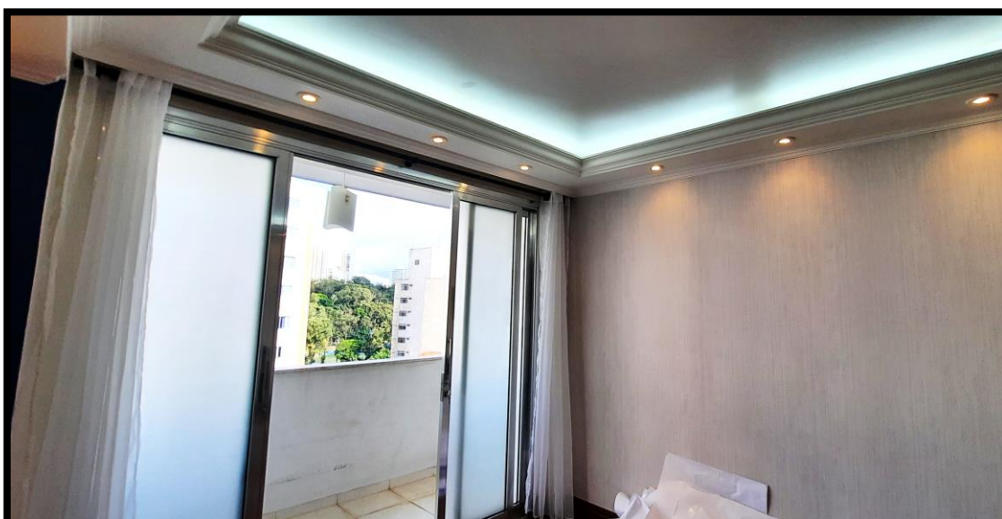
IMAGEM 27- VISÃO DO FORRO DE SANCA COM ILUMINAÇÃO DA SALA DE ESTAR
