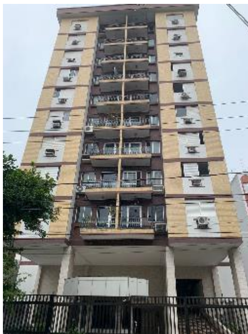
IMAGEM 1 FACHADA FRONTAL DO CONDOMÍNIO AUTOR
