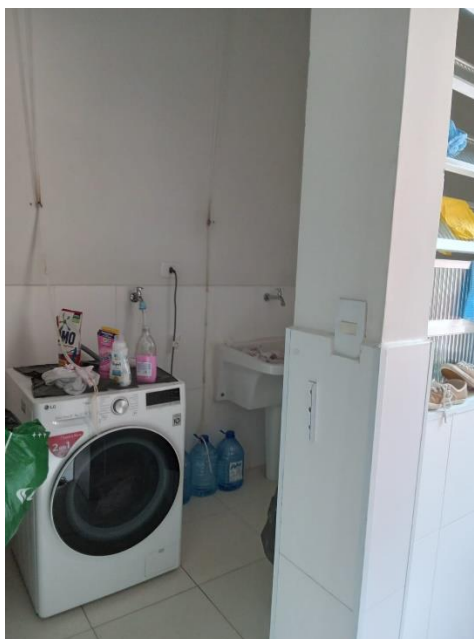
FOTO 09:- Vista da área de serviço do imóvel.
