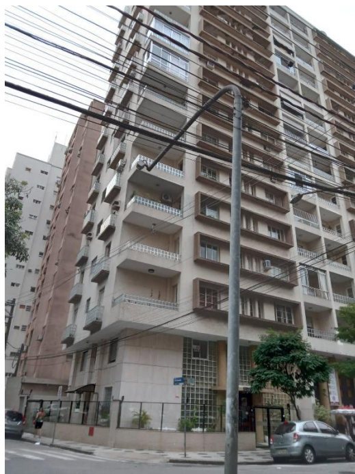
FOTO 01: - Vista da fachada geral do empreendimento.
