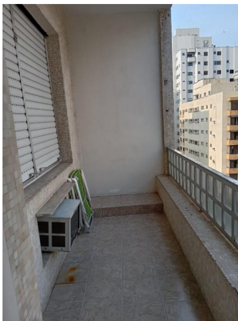
FOTO 05:- Vista da sacada do imóvel.
