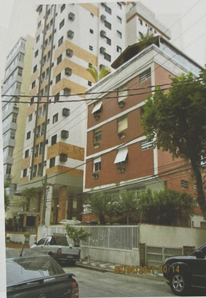
Foto 01 - Fachada frontal e lateral esquerda do Edifício Cauê.
