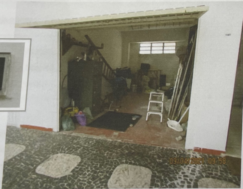
Fotos 18 e 19 - Garagem 4 no piso térreo.
