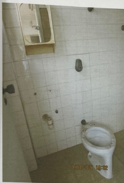
Fotos 15/17 - Area de serviço e dependência de empregada.
