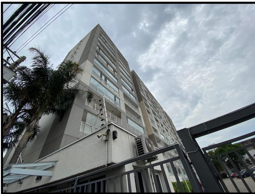
Imagem 1 – Fachada do Edifício
