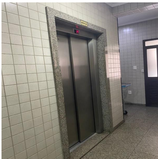
Figura 4: Porta Elevador de Serviço - Pavimento Térreo
