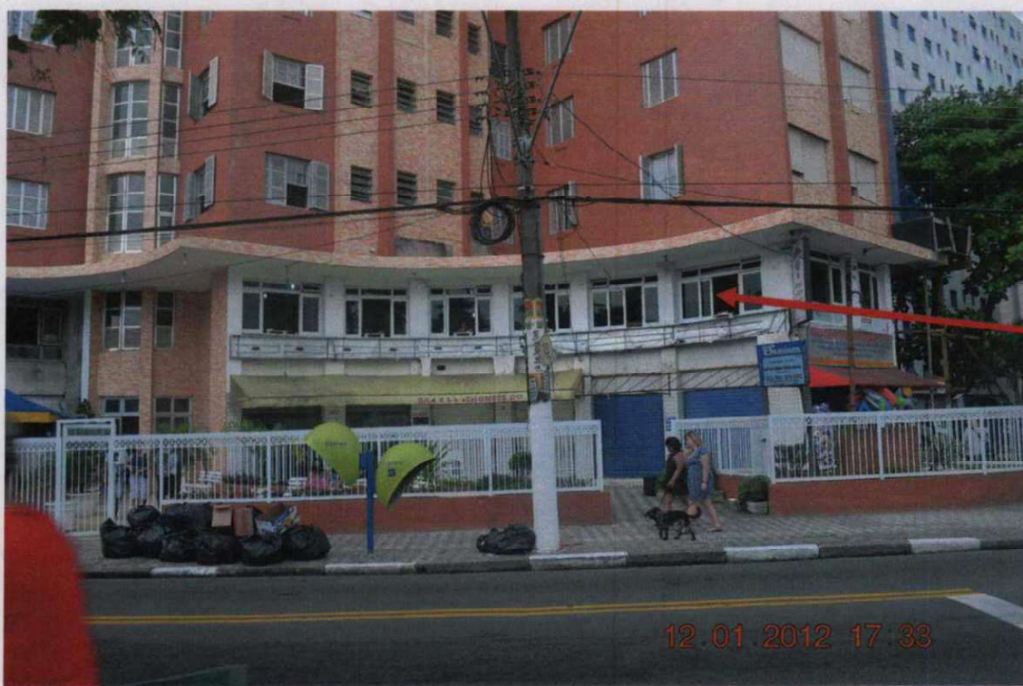
FOTO 01 :- Vista frontal do bem avaliando, note a sobreloja.
