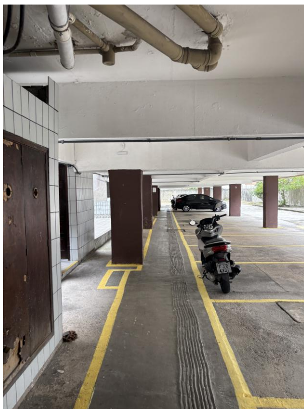
Figura 6: Vista generalizada da garagem sob pilotis.
