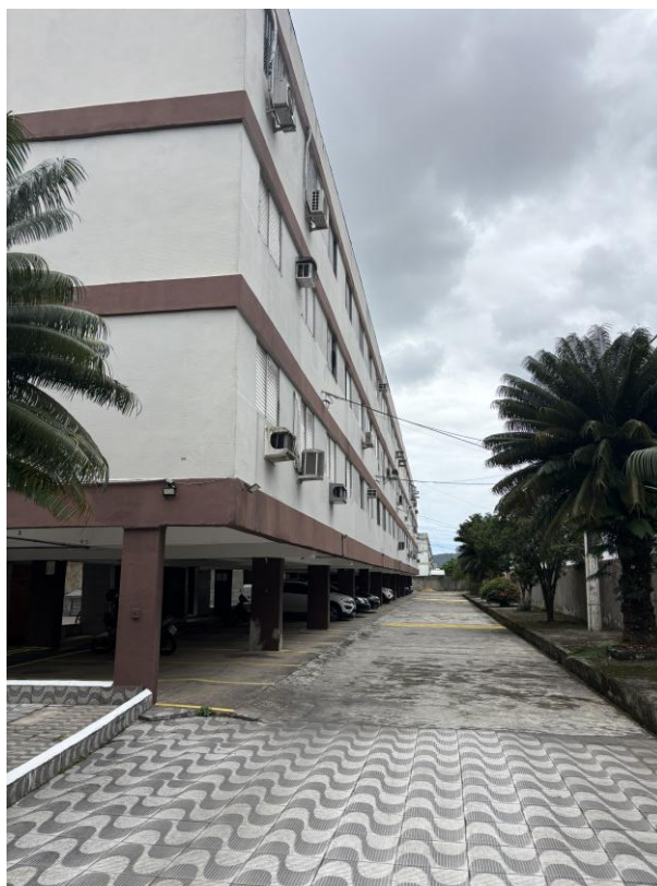
Figura 5: Vista do corredor lateral para circulação de veículos.
