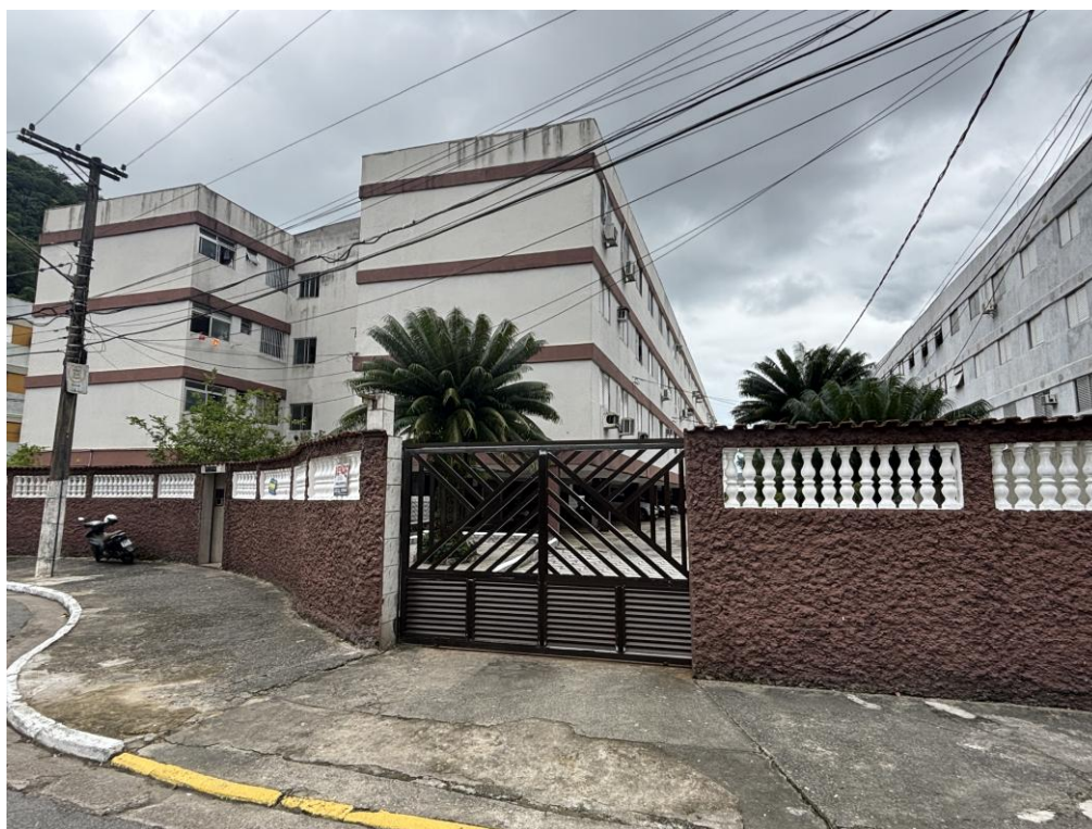
Figura 3: Vista da entrada/ frente do Edifício Airton Sena.
