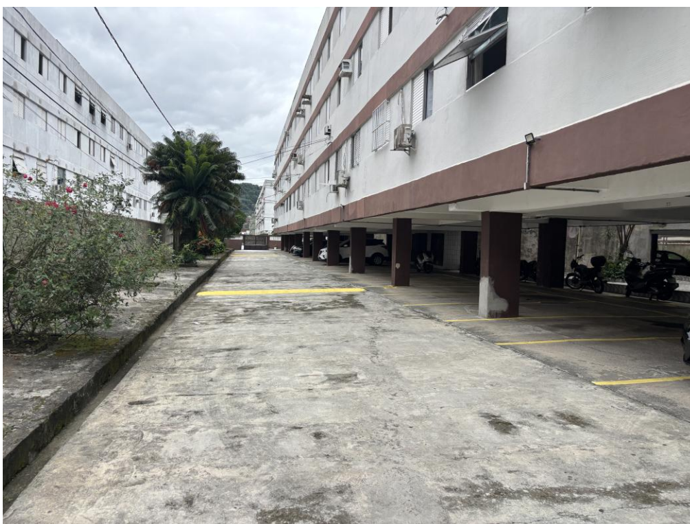
Figura 8: Vista geral das áreas externas do prédio.
