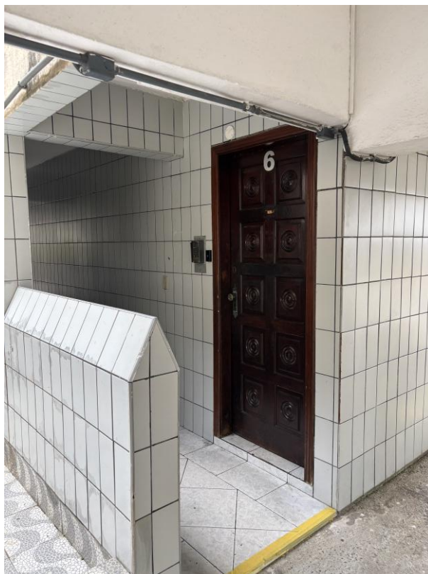
Figura 7: Vista da Porta 6.
