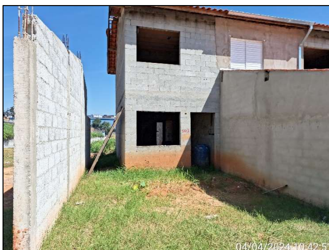
Foto 8. Residência em construção
