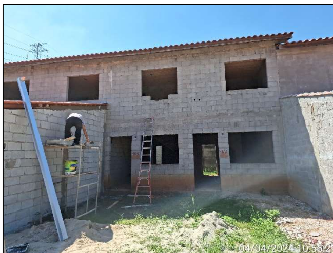
Foto 10. Residência em construção
