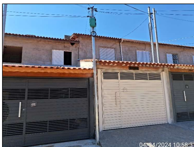
Foto 11. Residências em construção
