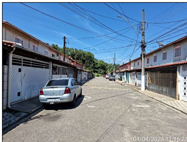
Foto 13. Rua interna do condomínio
