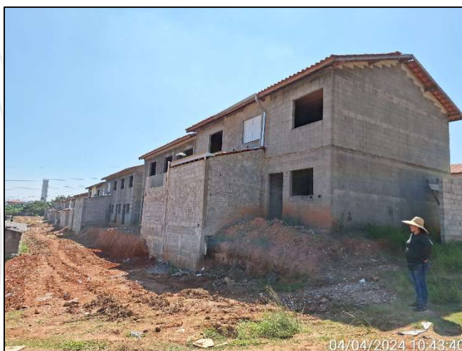
Foto 9. Residências em construção
