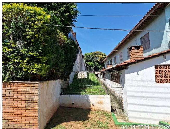
Foto 15. Área comum do condomínio
