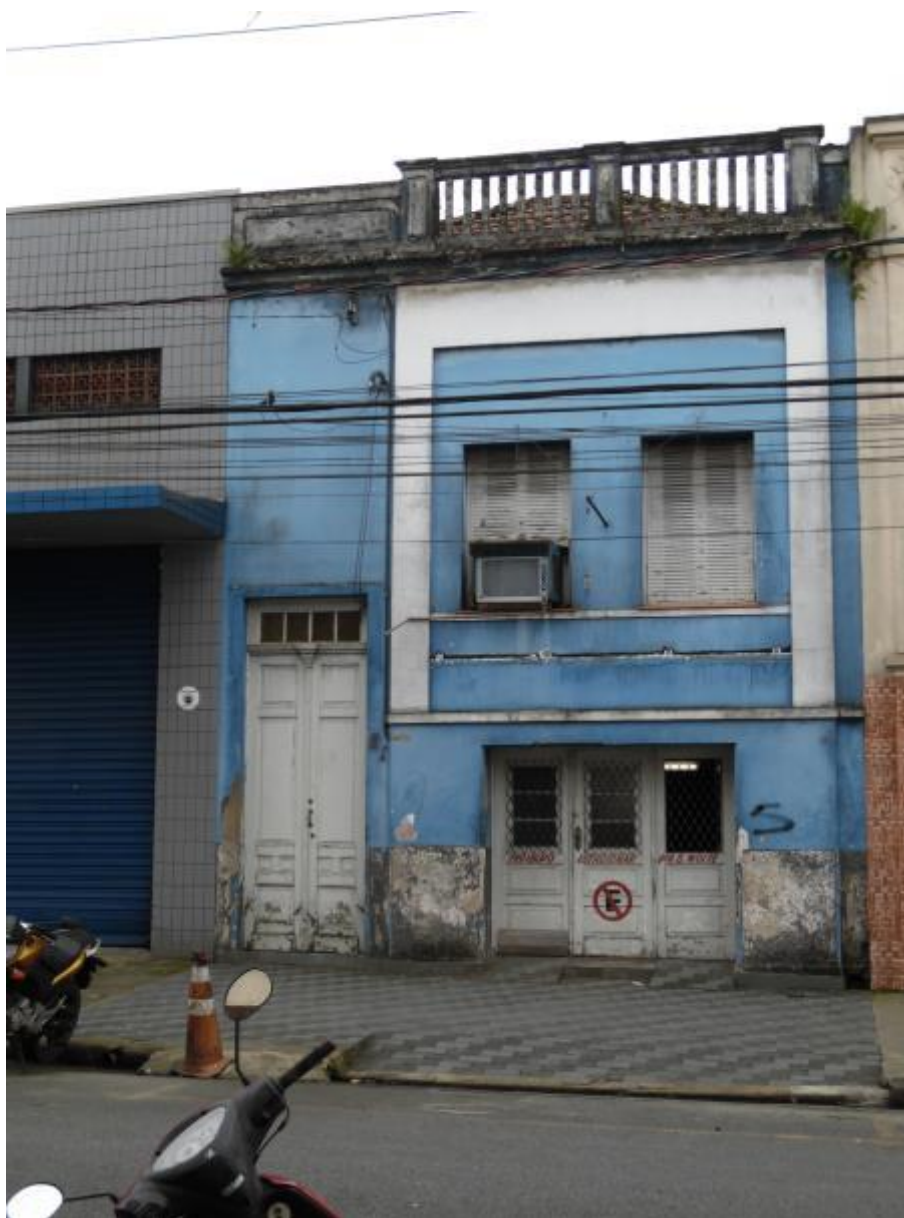
FOTO 02:- Vista do imóvel.
