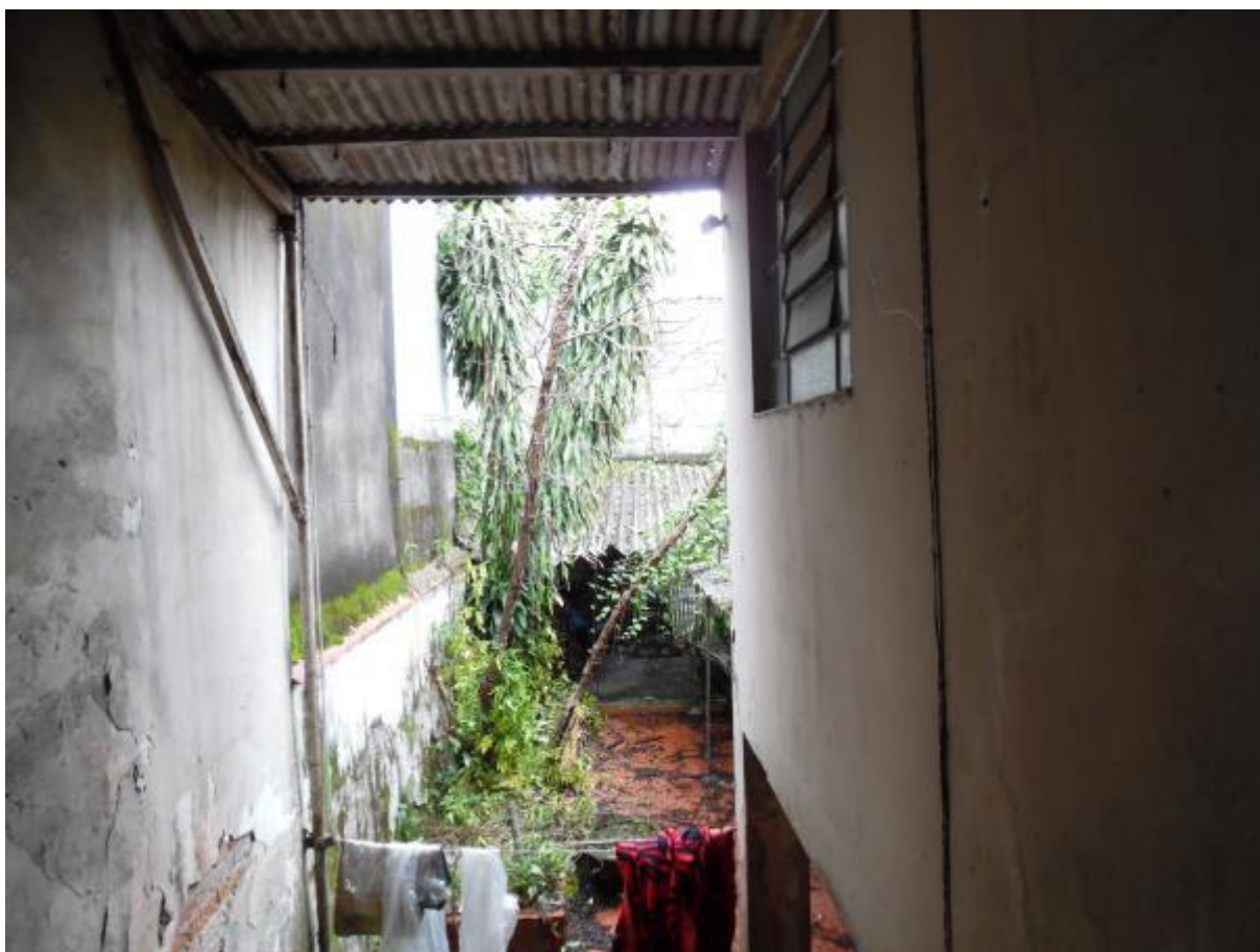
FOTO 08:- Vista do quintal do imóvel.
