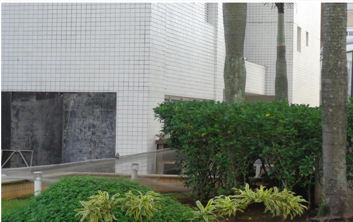
Vista da Torre A, em manutenção.
