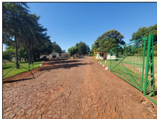
Figura 9 - Aspecto geral do portão de entrada
