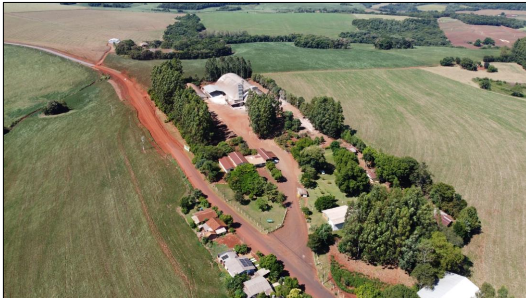
Figura 3 - Foto aérea do imóvel vistoriado
