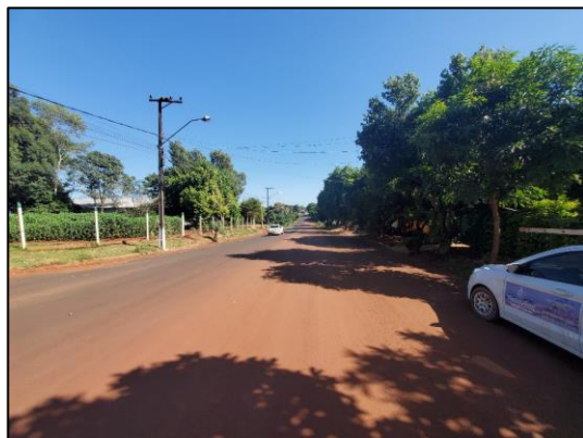
Figura 8 - Aspecto geral da rua de acesso do imóvel
