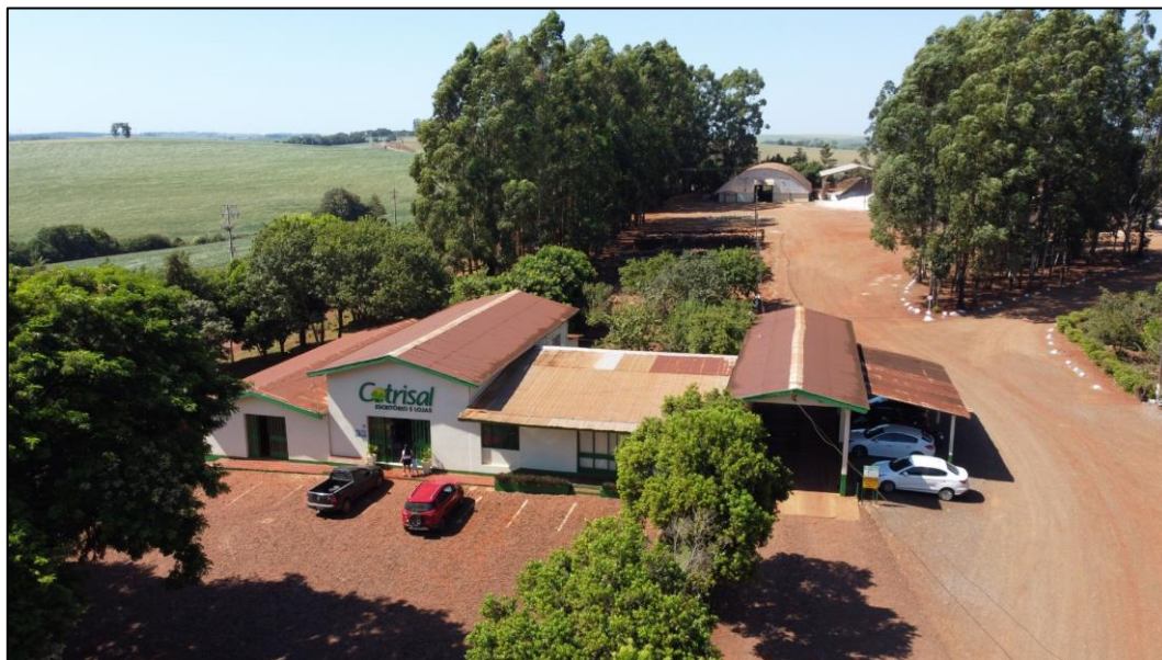
Figura 6 - Foto aérea do imóvel vistoriado
