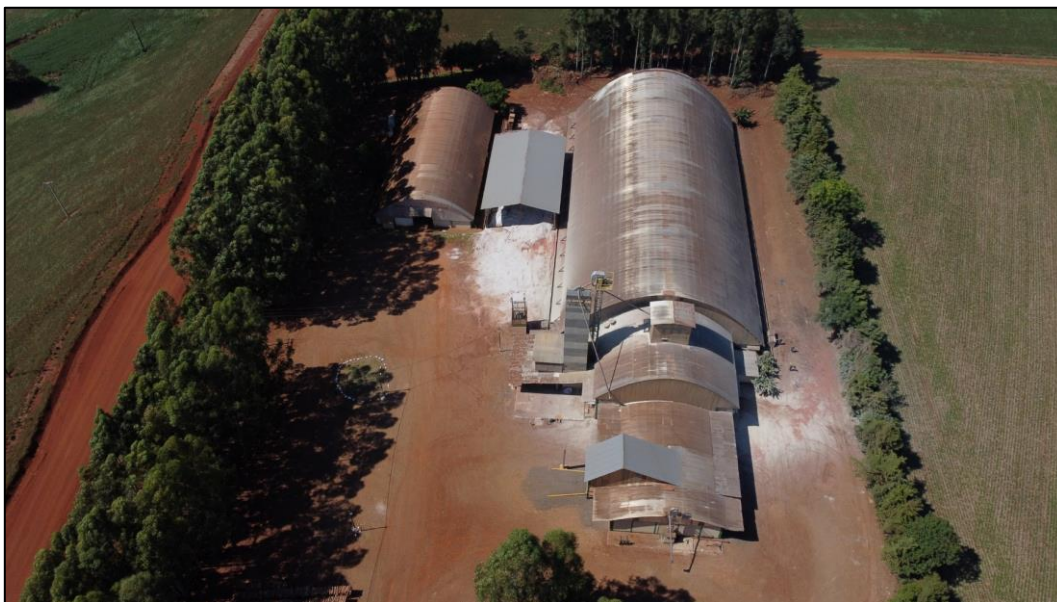
Figura 5 - Foto aérea do imóvel vistoriado
