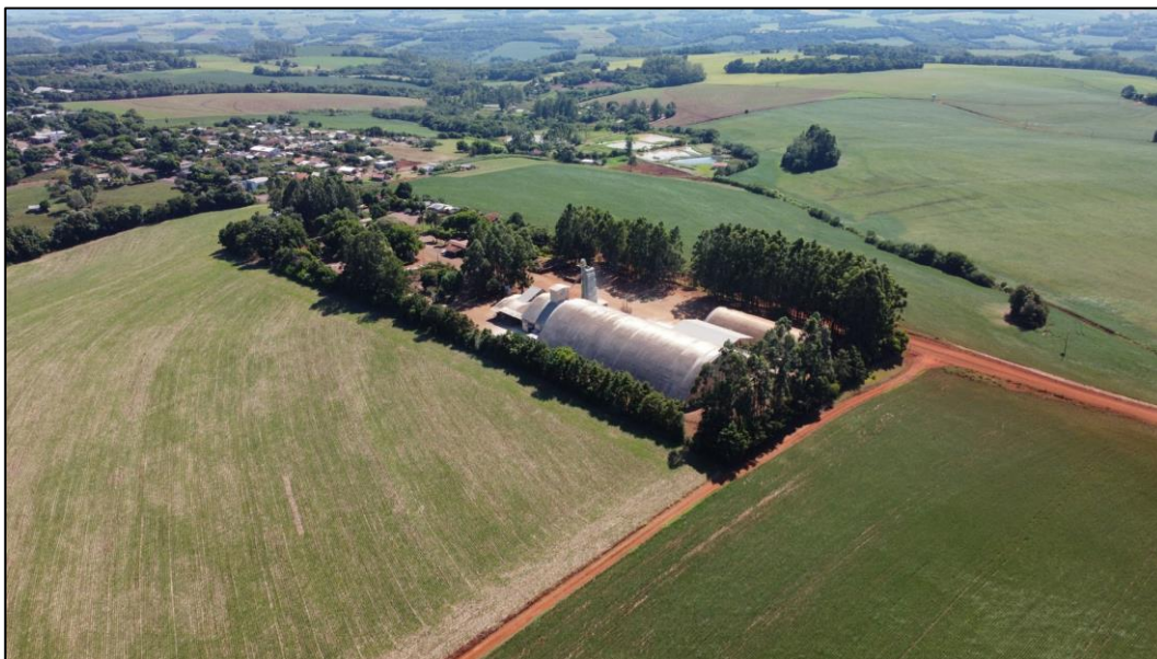
Figura 4 - Foto aérea do imóvel vistoriado
