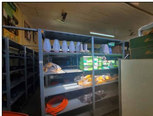
Figura 29 - Aspecto do interior da edificação
