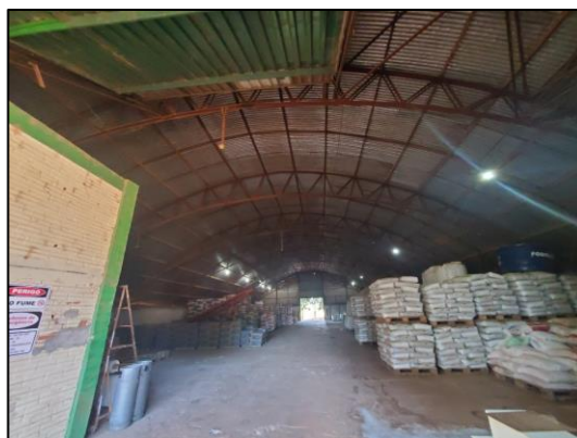
Figura 43 - Aspecto do interior da edificação
