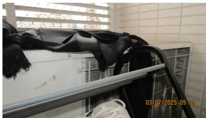
Foto 100 – Outra vista da área técnica do imóvel avaliando.
