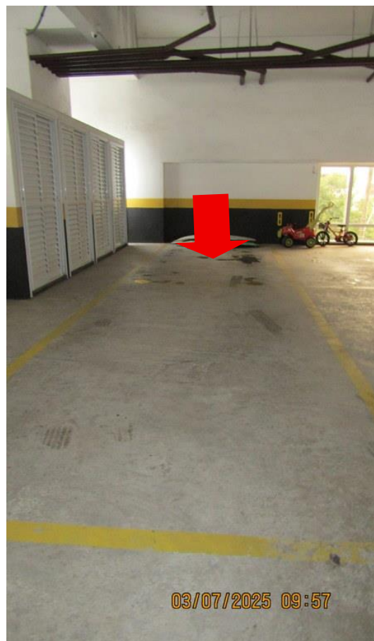
Foto 110 – Outra vista da vaga de garagem do apartamento nº 31, localizada no pavimento G2.
