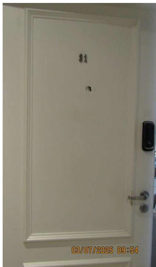
Foto 30 - Detalhes do acesso ao apartamento nº 31.
