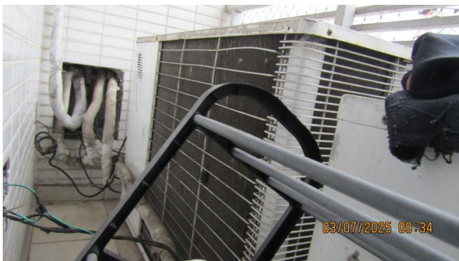
Foto 98 – Outra vista da área técnica do imóvel avaliando.
