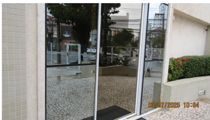
Foto 19 – Vista do acesso ao hall de entrada do Condomínio Residencial Pátio Suplicy.
