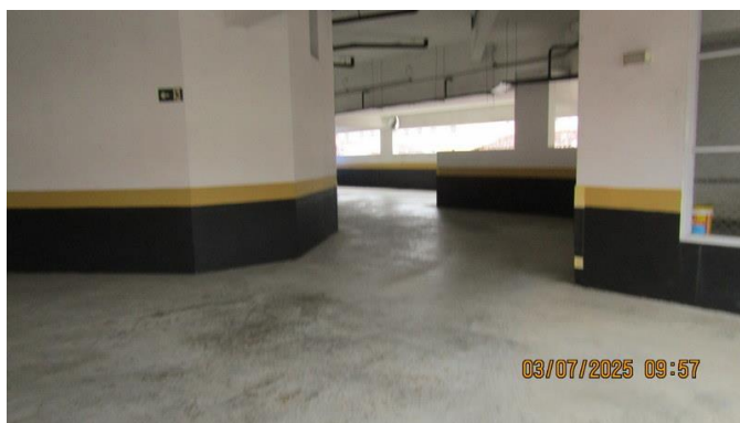
Foto 107 - Outra vista da garagem localizada no pavimento G2.
