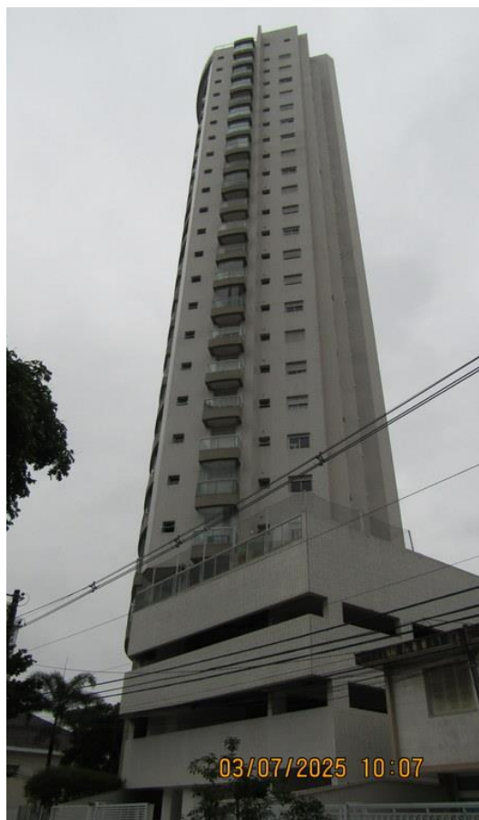
Foto 10 - Outra vista da fachada do Condomínio Residencial Pátio Suplicy.
