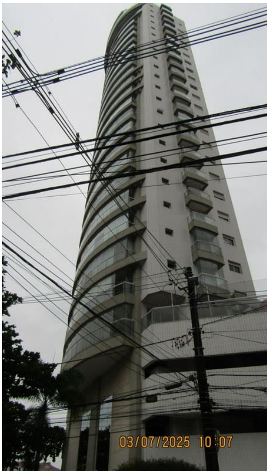
Foto 7 – Detalhes da fachada do Condomínio Residencial Pátio Suplicy.
