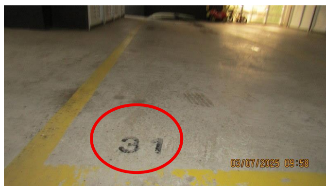
Foto 108 - Vista da vaga de garagem do apartamento nº 31, localizada no pavimento G2.
