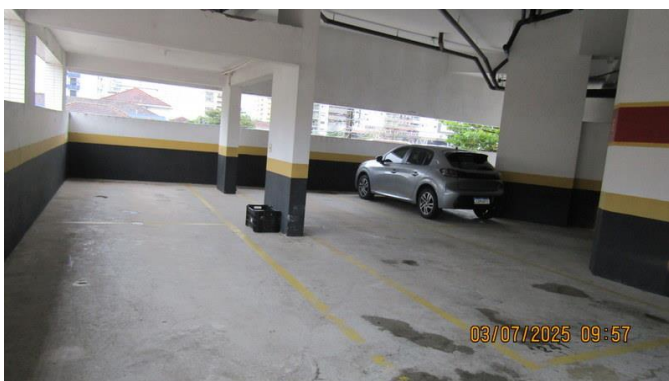
Foto 106 - Vista da garagem localizada no pavimento G2.
