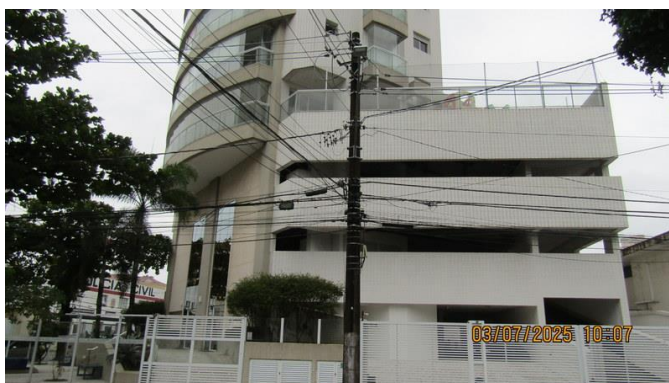
Foto 12 - Detalhes da fachada do Condomínio Residencial Pátio Suplicy.
