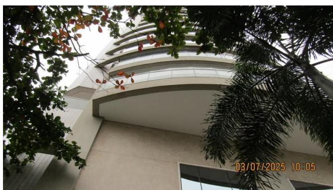
Foto 13 Detalhes da fachada do Condomínio Residencial Pátio Suplicy.
