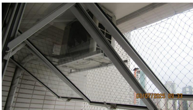
Foto 99 - Outra vista da área técnica do imóvel avaliando.
