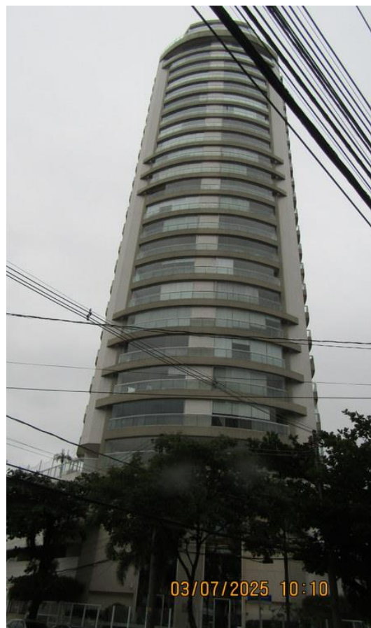
Foto 8 – Outra vista da fachada do Condomínio Residencial Pátio Suplicy.
