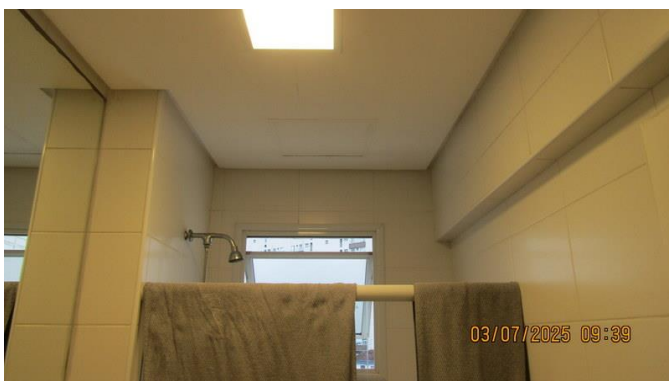
Foto 76 - Outra vista do banheiro do imóvel avaliando.
