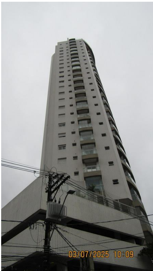
Foto 9 - Outra vista da fachada do Condomínio Residencial Pátio Suplicy.
