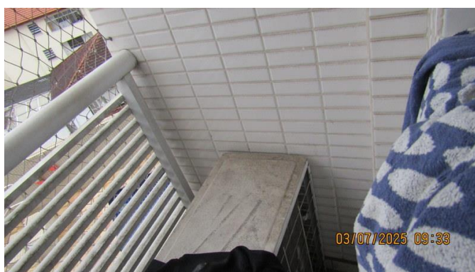
Foto 95 - Outra vista da área técnica do imóvel avaliando.
