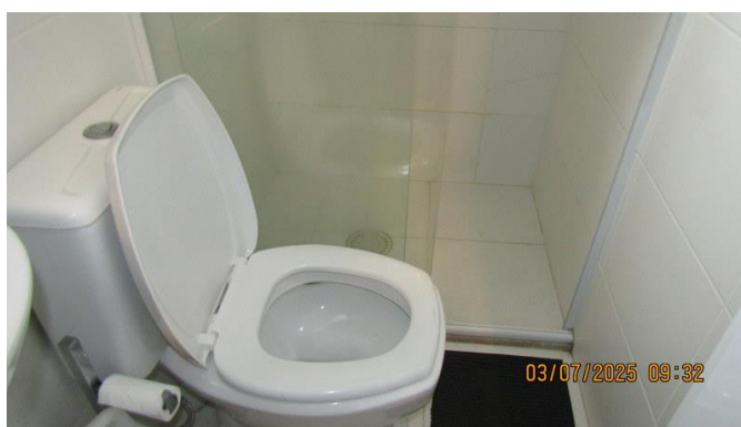
Foto 105 – Outra vista do WC do imóvel avaliando.
