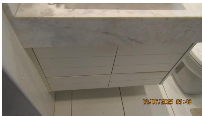
Foto 75 – Detalhes do banheiro do imóvel avaliando.
