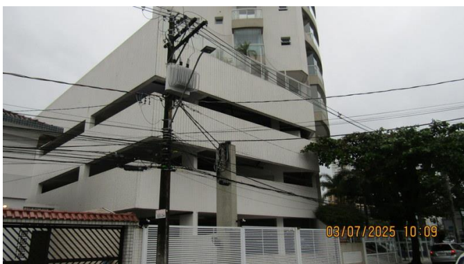
Foto 11 – Detalhes da fachada do Condomínio Residencial Pátio Suplicy.
