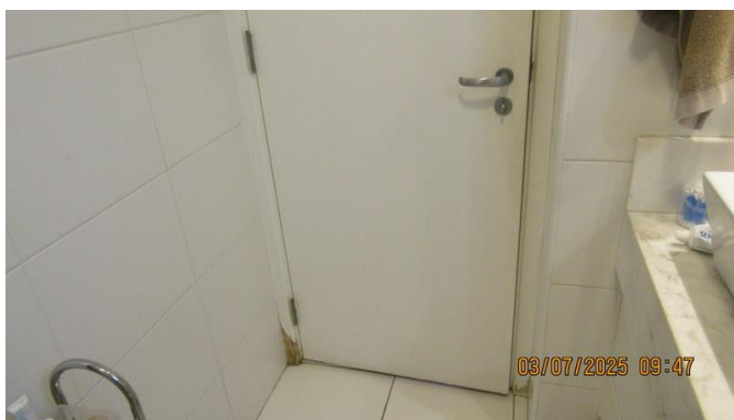
Foto 74 – Detalhes do banheiro do imóvel avaliando.
