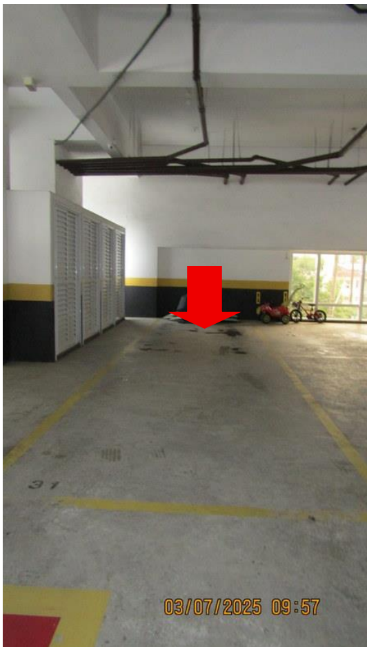
Foto 109 – Outra vista da vaga de garagem do apartamento nº 31, localizada no pavimento G2.
