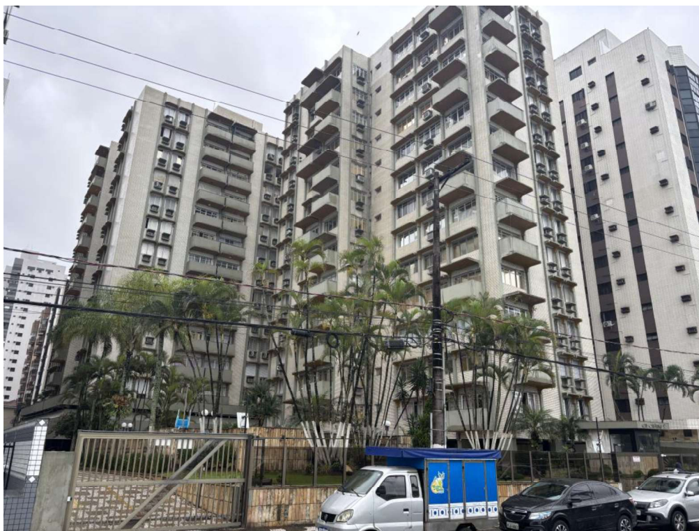
Figura 3: Vista geral do Condomínio Costa Blanca.
