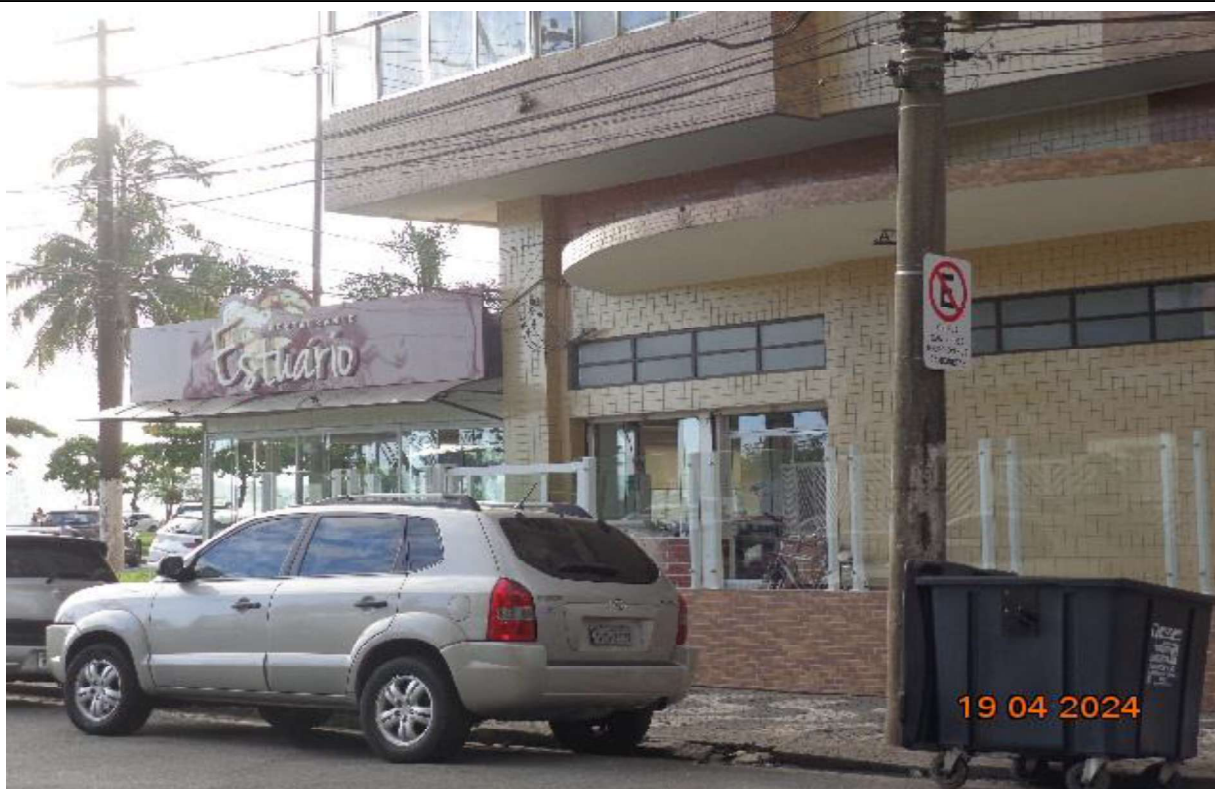
FOTO 17: Vista de uma das lojas no pavimento térreo, com vista para a Av. Bartolomeu de Gusmão.
